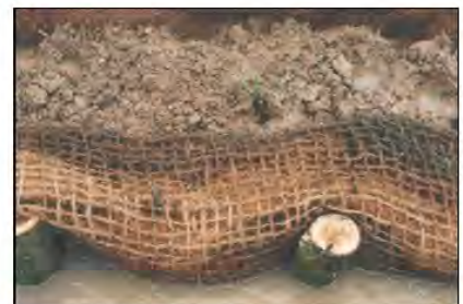
Détail de réalisation à la fin des travaux
