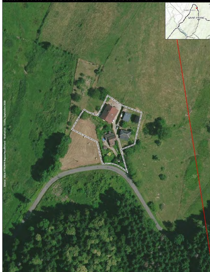
Secteur de discontinuité du Gazon - Commune de Saint-Franc
