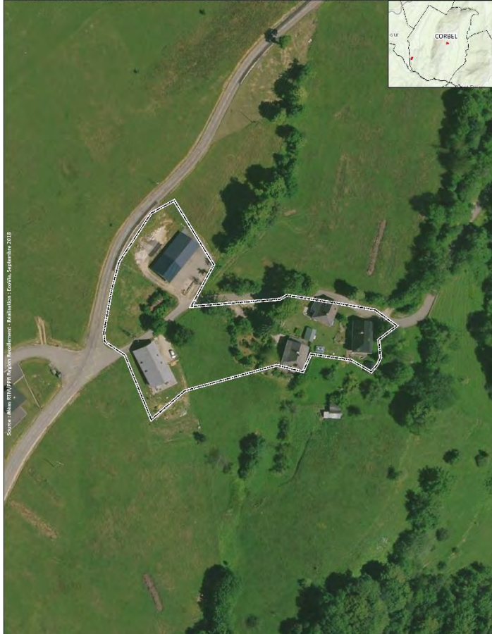
Secteur de discontinuité des Perruchons - Commune de Corbel
