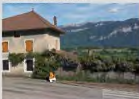
Miribel les Echelles: mur de soutènement végétalisé structurant l'espace public
