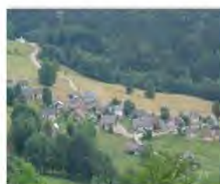
Hameau de Saint-Même-d'en-Haut: le sens du faitage est perpendiculaire aux courbes de niveau, la trame bâtie est dense et serrée sous forme de maisons individuelles mitoyennes ou non.
