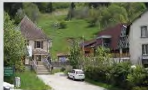
Saint Pierre de Chartreuse: caisse des remontées mécaniques: la trame végétale valorise l'entrée et adoucit la transition entre espace habitat permanent et activité touristique
