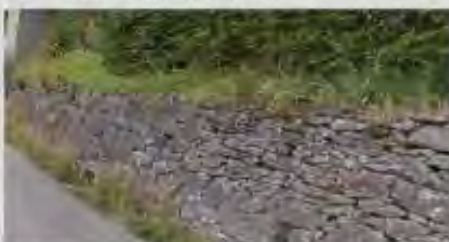
Miribel les Echelles: mur de soutènement surplombé d'une bande végétale
