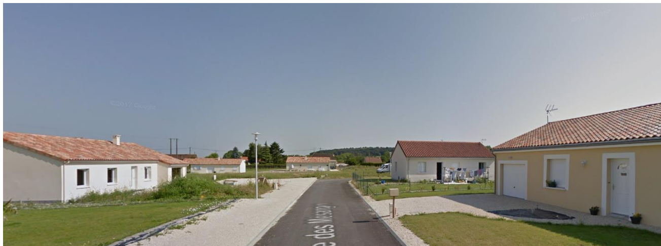
Lotissement existant à côté du site Allée des Mésanges
