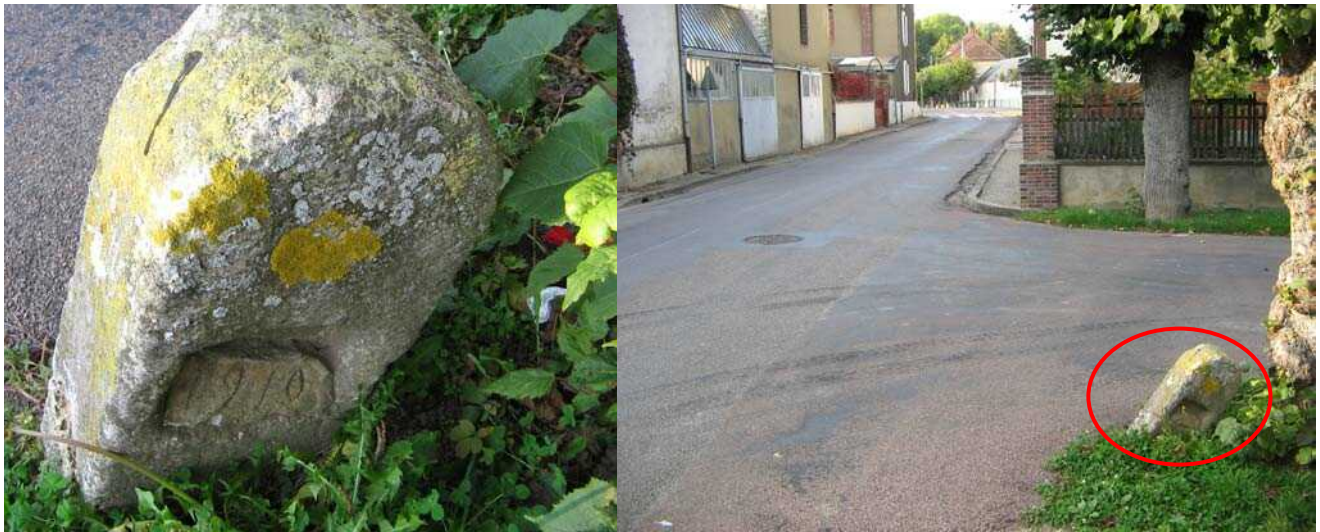
Repère présumé de la crue de 1910 à Aillant-sur-Tholon
