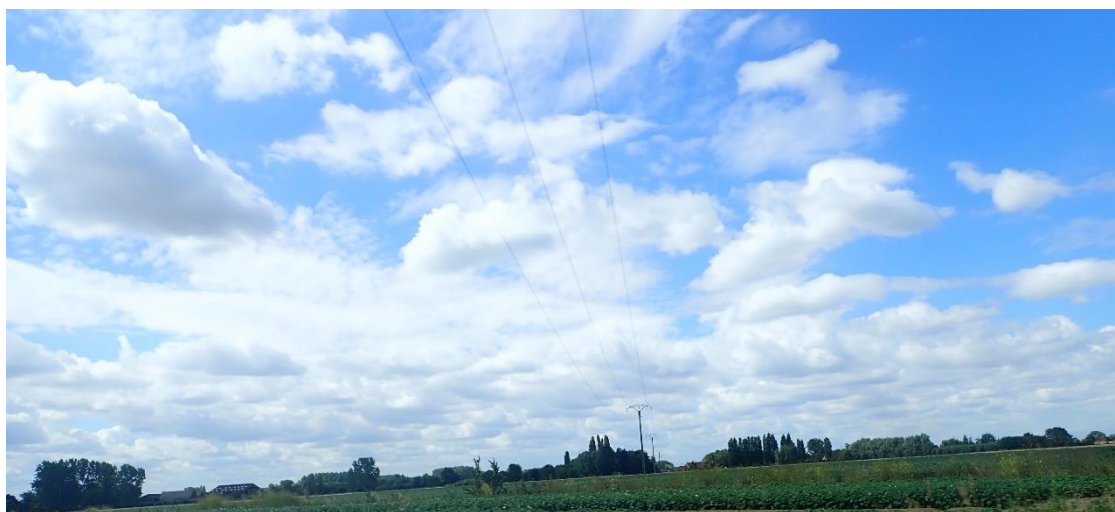
La ligne électrique passant au sud-est de la commune
