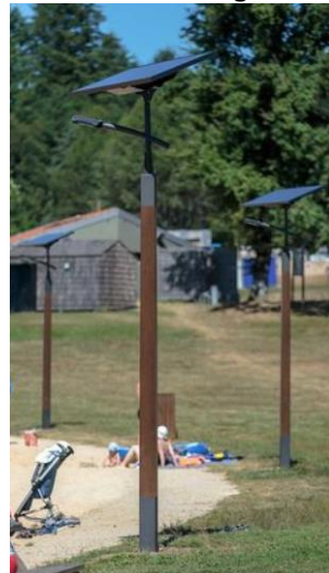
Candélabres à énergie solaire
