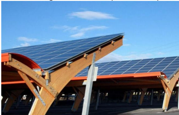
Parking sous ombrière photovoltaïque
