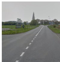
La RD172E3 est une voie primaire large ne disposant pas de trottoir, ni d'éclairage public
