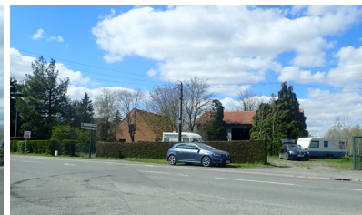
La ligne électrique et son pylône implantés sur la zone
