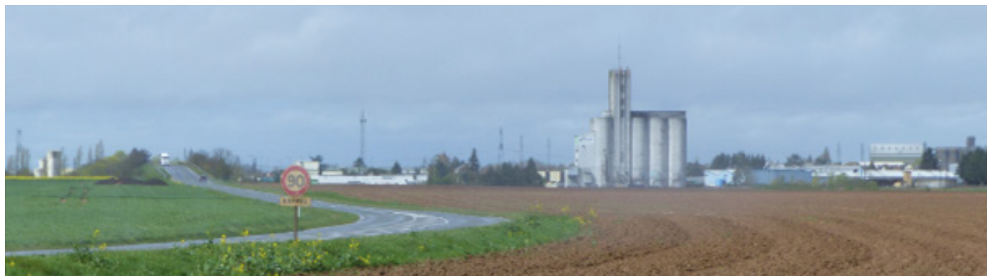
Vue depuis le carrefour RD927 - route d'Armonville
