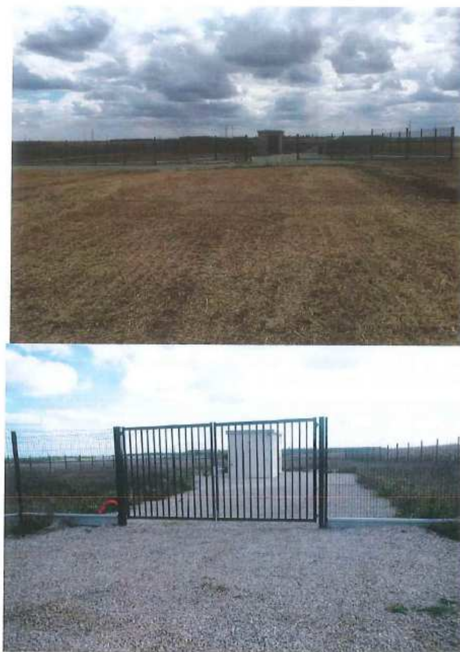
Figure 6. Périmètre de protection immédiate du captage F1 (30/09/2019)
