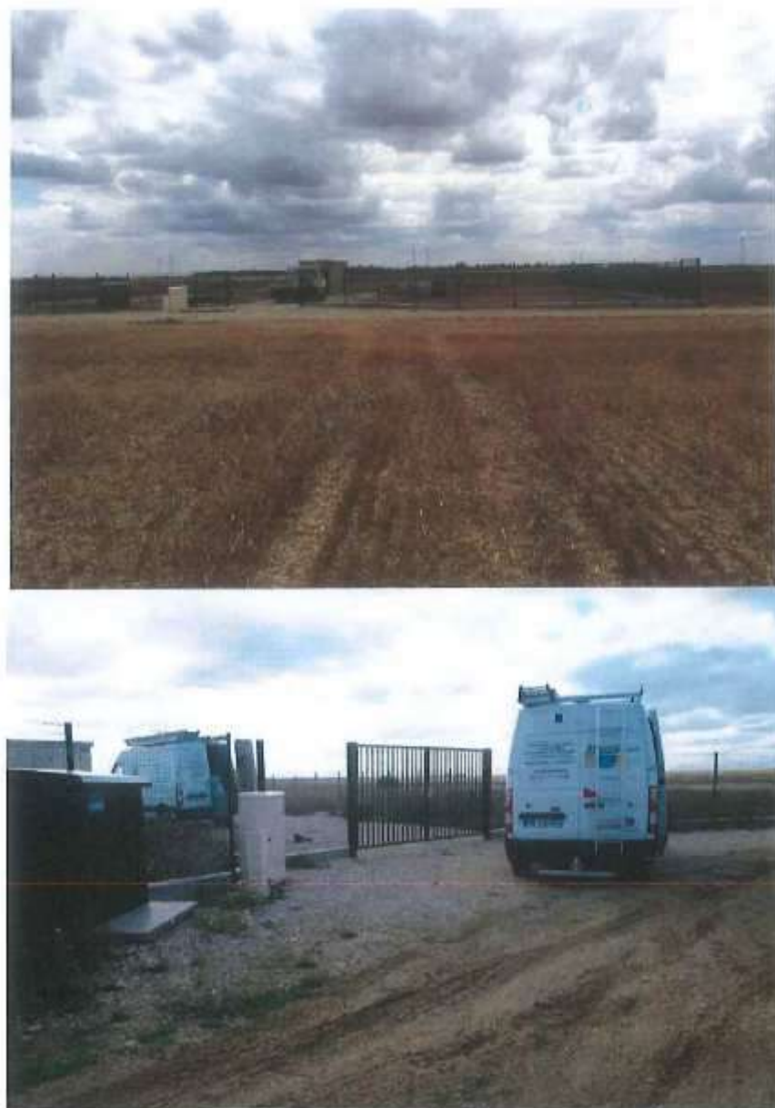
Figure 7. Périmètre de protection immédiate du captage F2 (30/09/2019)
