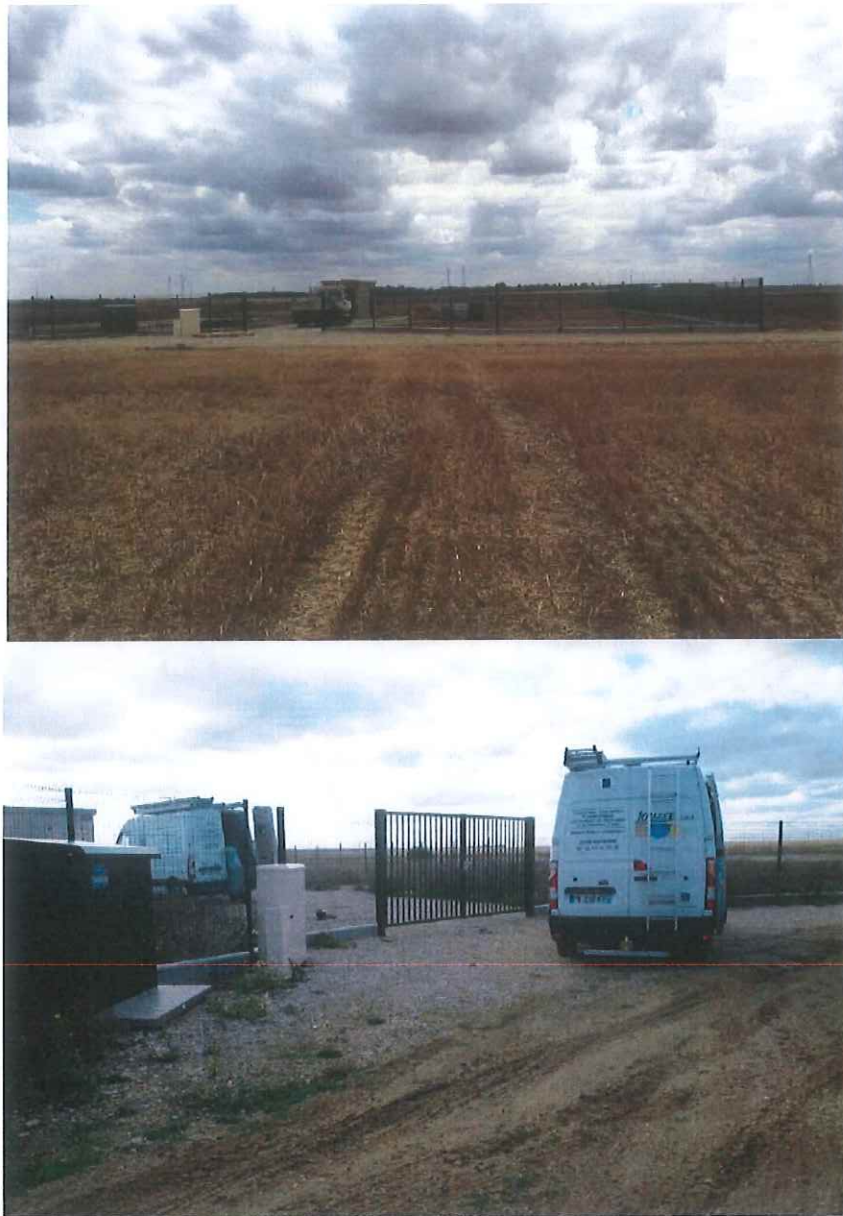
Figure 7. Périmètre de protection immédiate du captage F2 (30/09/2019)
