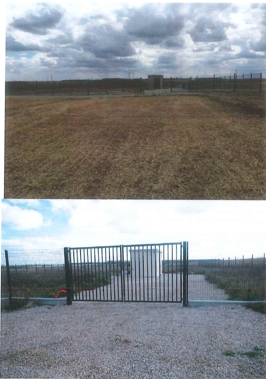
Figure 6. Périmètre de protection immédiate du captage F1 (30/09/2019)
