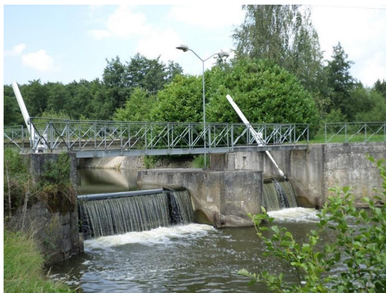
La Sambre à l'écluse de Sassegny (Crédits photo : villesetvillagesdelavesnois.org)
