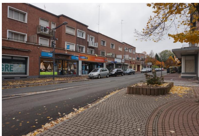
Architecture de la reconstruction à Maubeuge
