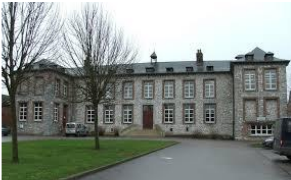
La mairie de Ferrière-la-Petite (source : villesetvillagesdelavesnois.org)
