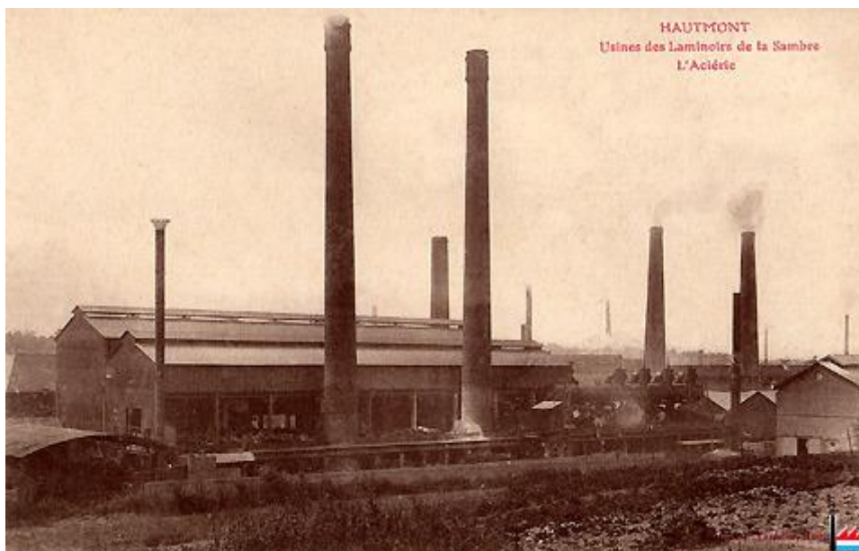
Usines des Laminoirs de la Sambre, Hautmont, L'aciérie (source : industrie.lu)
