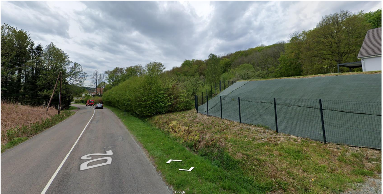
Vue sur le secteur en discontinuité (bord droit de la voie, végétalisé), source : Google Street View, mai 2021
