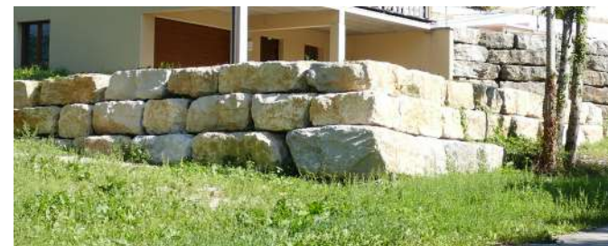
Utilisation d'enrochement pour combler une inadaptation à la pente - Le Souillot (Chapelle-d'Huin)
