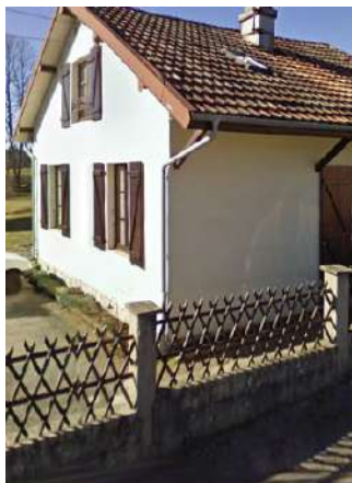
Clôture basse réalisée avec un soubassement béton et grillage treillis bois - Villers-sous-Chalamont
