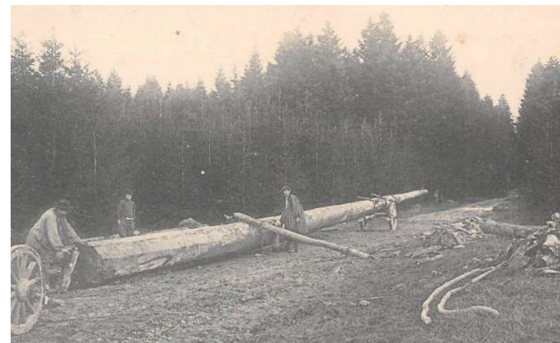
Chargement d'un Sapin (Villeneuve-d'Amont) - Delcampe
