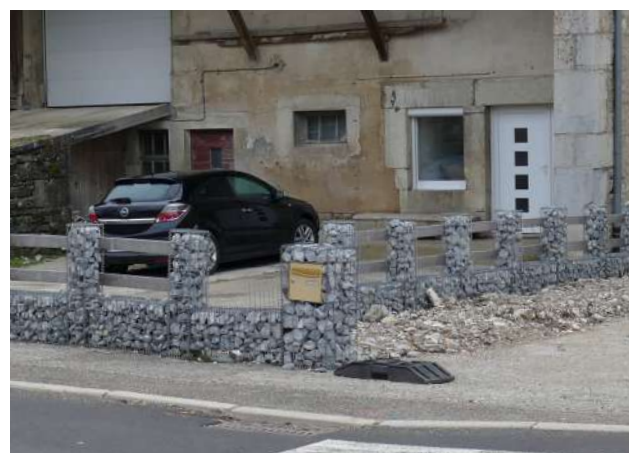
Exemple d'un muret bas en gabions - Évillers
