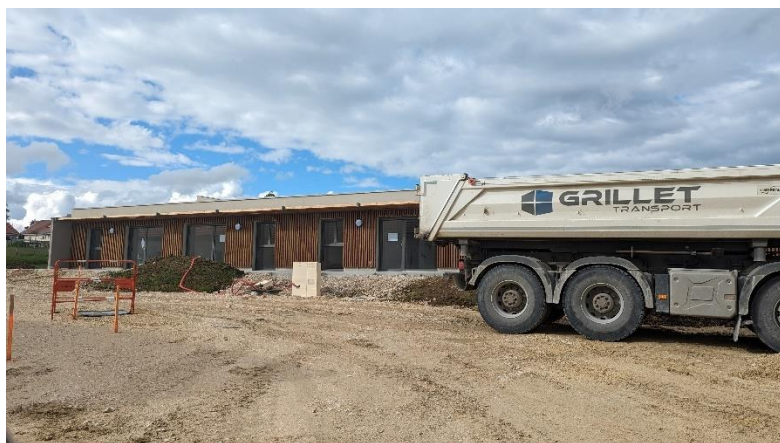
Photo 6 : Résidence seniors en chantier à Levier
