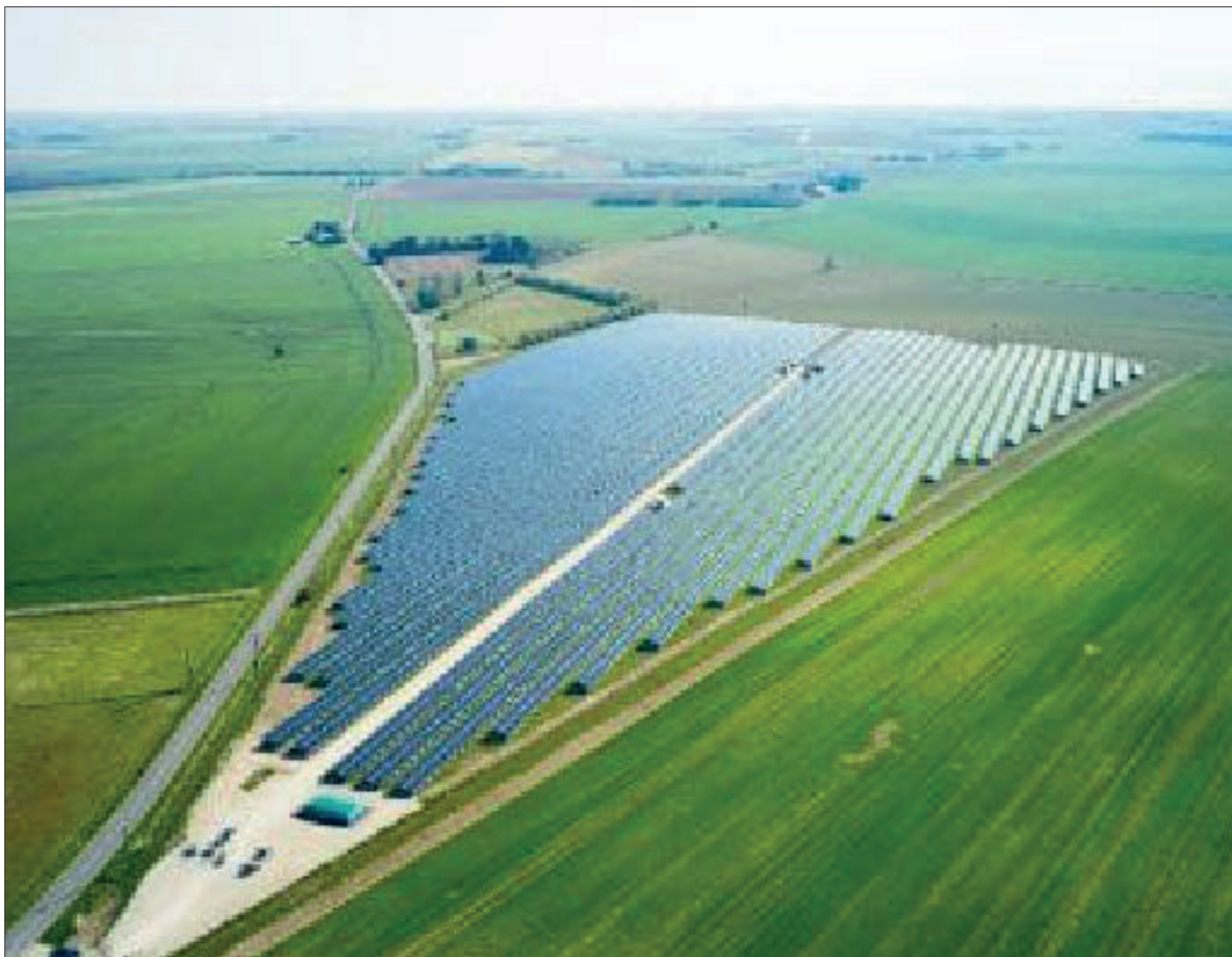
CENTRALE PHOTOVOLTAÏQUE DE LEVROUX
