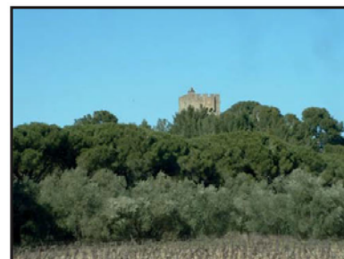
La tour Montrabech
