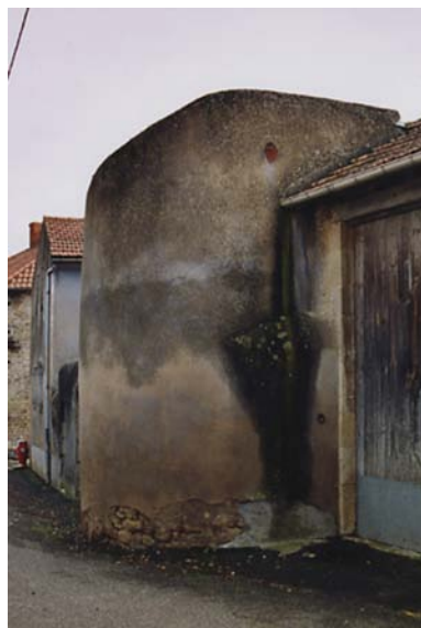
la tour n°1 - avant et après restauration
