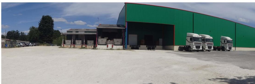
Vue sur les bâtiments et quais de l'entreprise Sartori.
