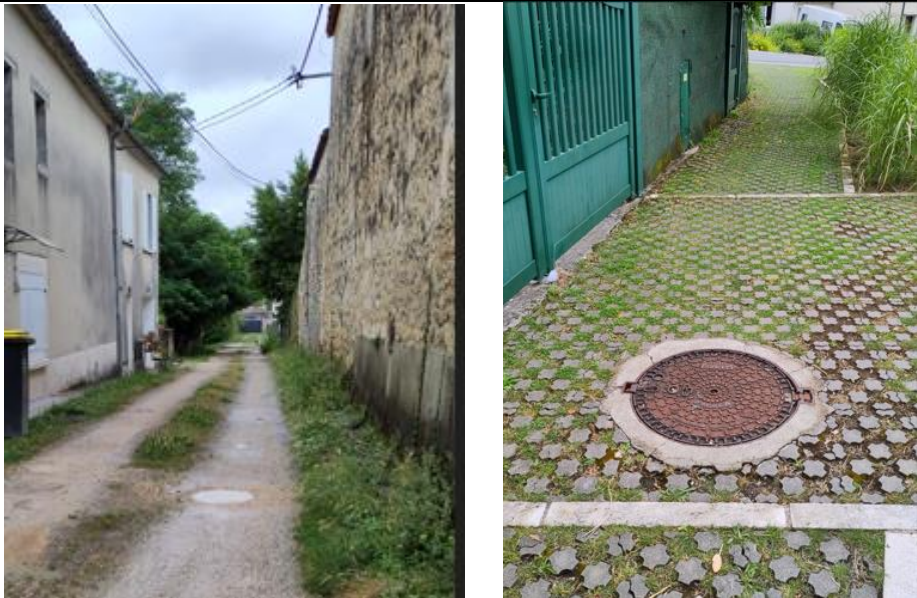
Photo 17 cours et cheminements en matériaux perméable
