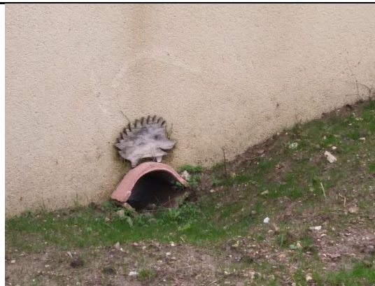
Photo 8 Passage faune dans mur ancien (source : site internet Mission Hérisson)
