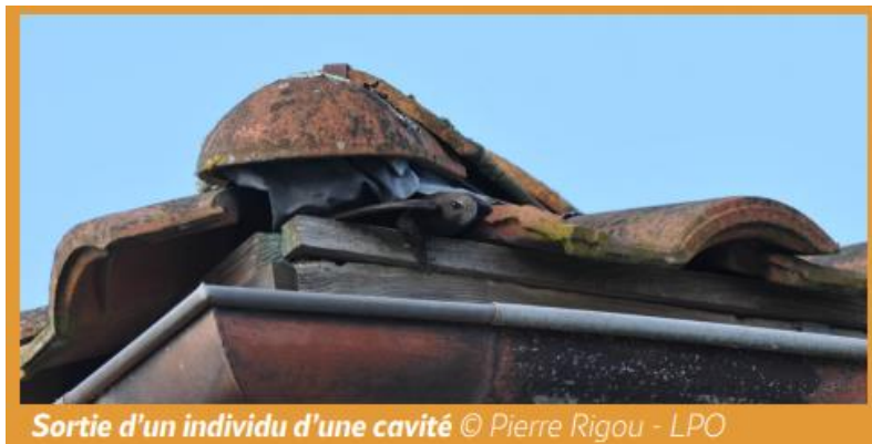
Photo 23 - Exemples de gîtes dans le bâti (Sources : Guide RÉNOVATION DU BÂTI ET BIODIVERSITÉ, LPO)
