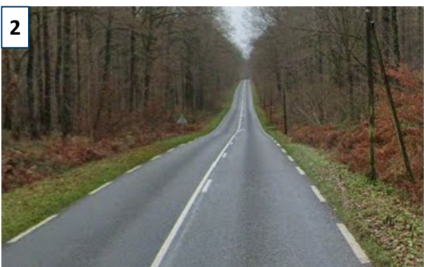
Aménagement d'une voie verte séparée de la voirie sur la Route de Savignies
