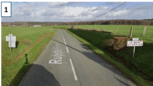
Création d'une CVCB sur la rue de Rome (RD626)
