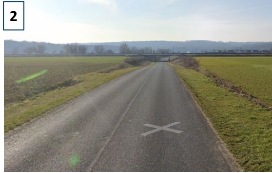
Aménagement d'une voie verte le long d'une voie communale
