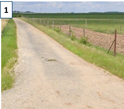
Voie verte à aménager sur un chemin existant
