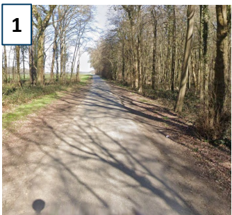
Voie verte à aménager sur une route communale peu fréquentée
