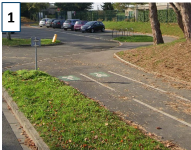
1 Piste cyclable bidirectionnelle existante sur la rue de Sénéfontaine (RD35)
