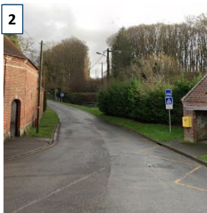
Jalonnement à créer sur le Bois du Courroie
