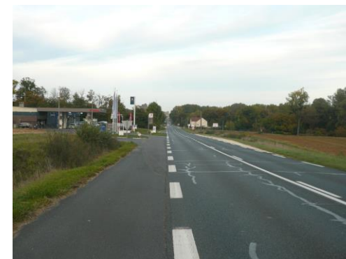
6. N151 : La vallée vue depuis l'ouest, avant la station-service, en légère cuvette avant l'entrée d'Issoudun.
