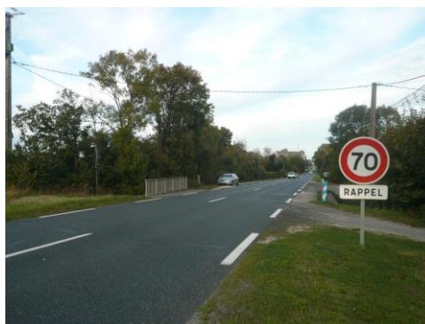
4. N151 : Pont sur le ruisseau de la Vignole, en face d'un accès à une propriété et d'une entrée de chemin, près d'accotements praticables pour le stationnement.
