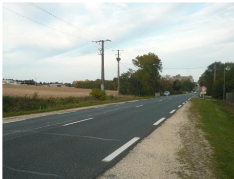
3. N151 : Accès agricole non aménagé, entre les deux poteaux des lignes électriques.
