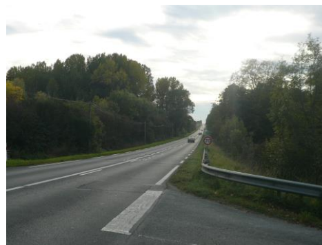
La N151 après la sortie d'agglomération d'Issoudun, en direction de Neuvy-Pailloux. L'automobiliste traverse la vallée boisée de la Vignole.
