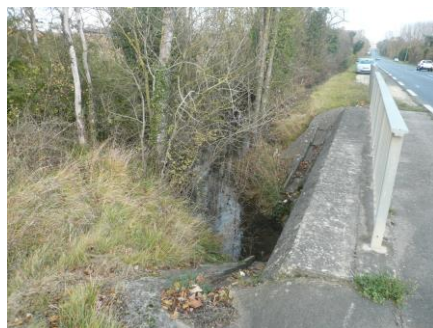
Ruisseau de la Vignole – passage sous la N151
