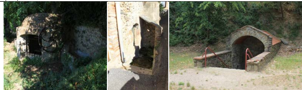
Puits ou pompe (a)
