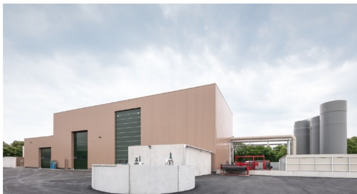
Figure 60 : Centrale biométhane du Dunois (VOL-V Biomasse)
