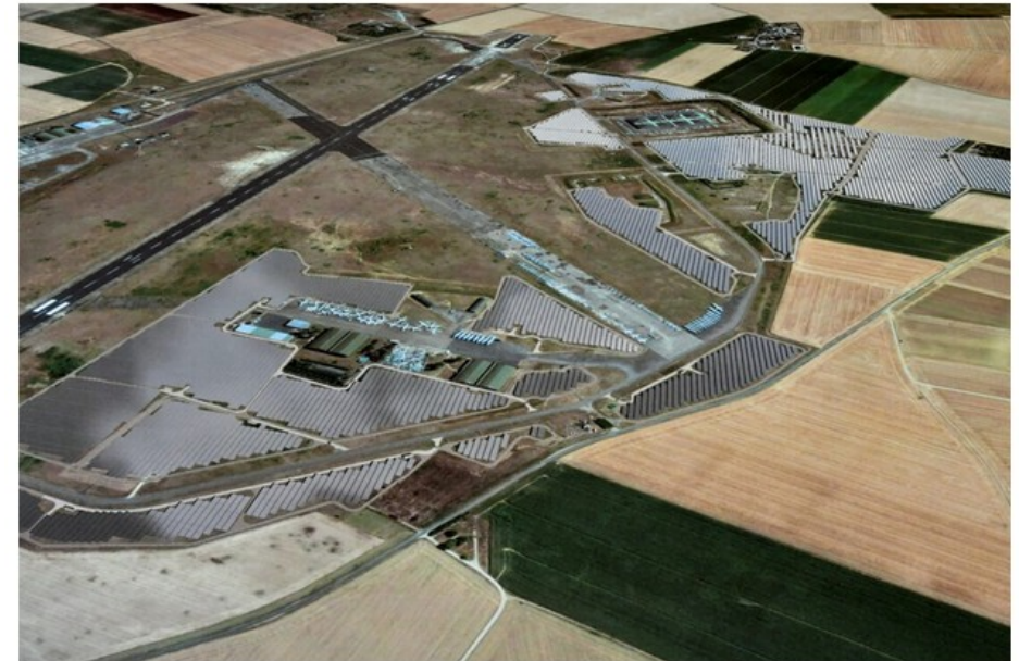
Une vue aérienne spectaculaire montrant ce que sera dans les deux années à venir la centrale solaire avec son emprise de 83 ha étudiée au mètre carré près pour rester compatible avec l'activité aéronautique. (©EDF Renouvelables)
