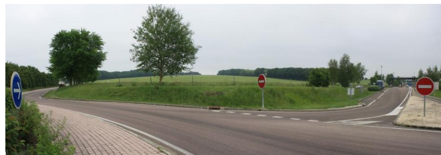
Vue du giratoire de la RD943 vers le site et la sortie du diffuseur autoroutier
