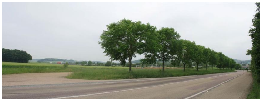
Vue de la RD943 vers le site
