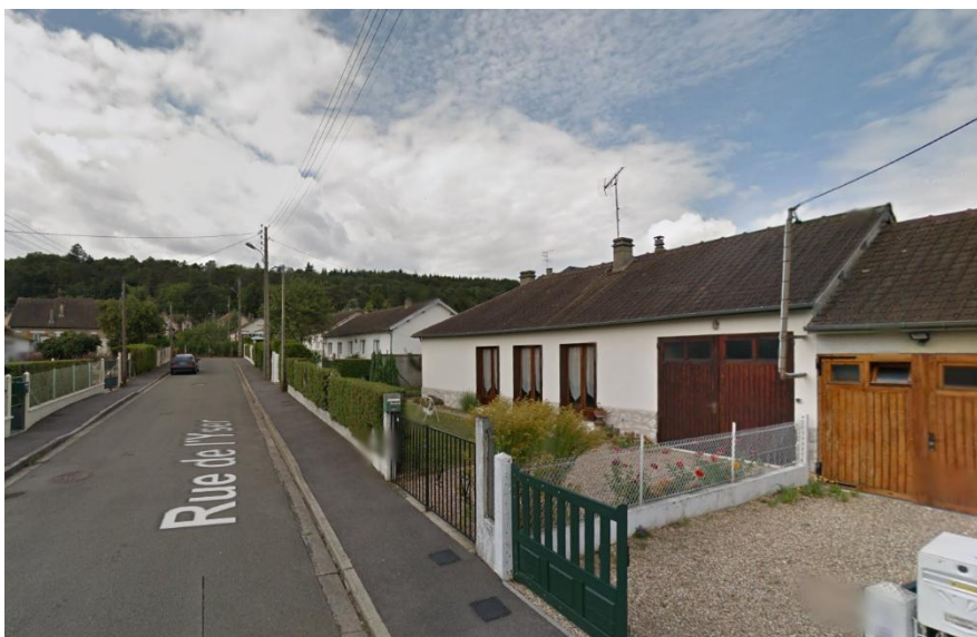
Louviers – rue de l'Yser
