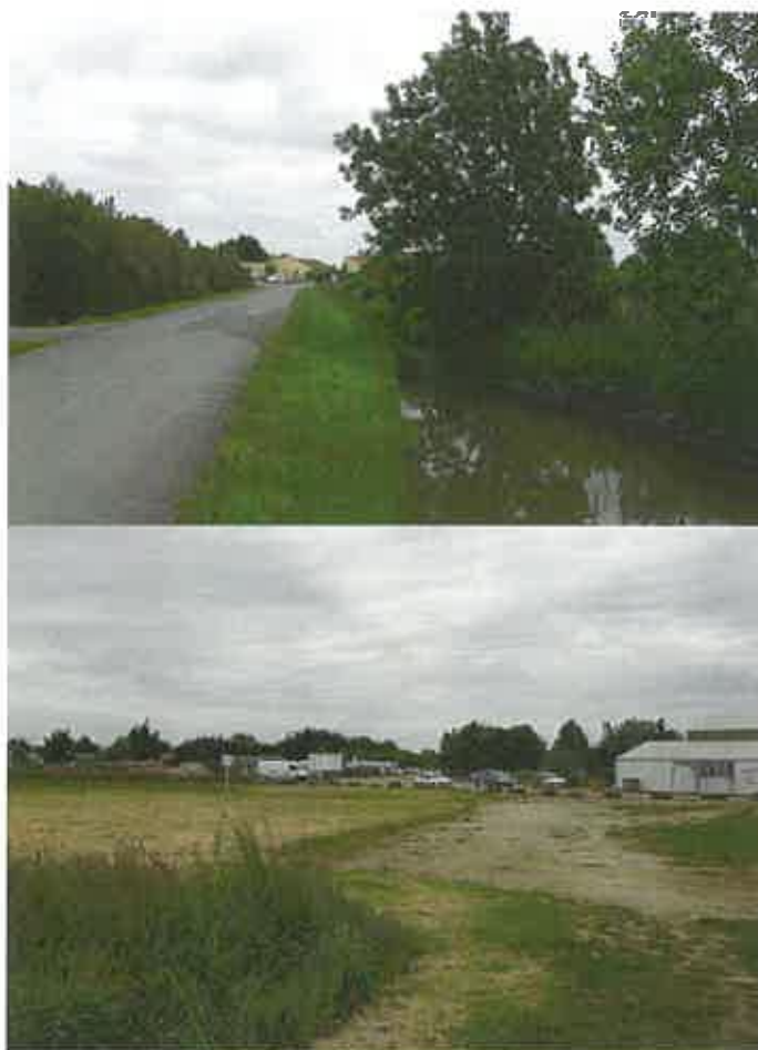
Figure 12 : La route du haras (mouillé) et le secteur des futures HLL (remblayé)
