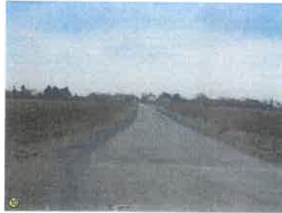
Vue sur le chemin de Marans depuis l'accès de la future zone commerciale. Chemin rural à requalifier dans la perspective d'une augmentation des trafics.
