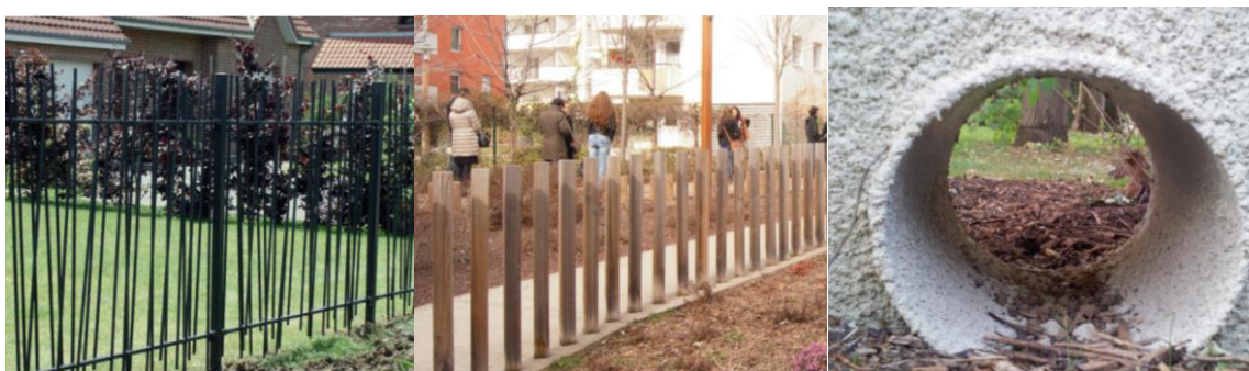
Schéma n°3. Exemple de séparation perméable à la petite faune – Ouverture en pied de murs
