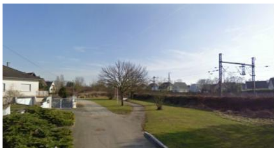
La rue du Chemin de Fer et la passage piéton sous la voie ferrée
