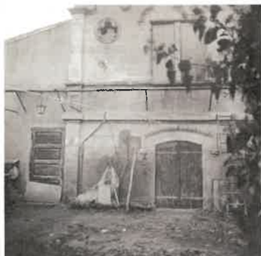
Façade principale, porte du rez-de-chaussée, état en 1976. Phot. Catherine Craveia IVR72_19763303802X
