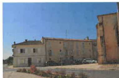
Vue d'ensemble du bâtiment construit en 2000. Phot. Florian Grollimund IVR72_20143305187NUC2A
