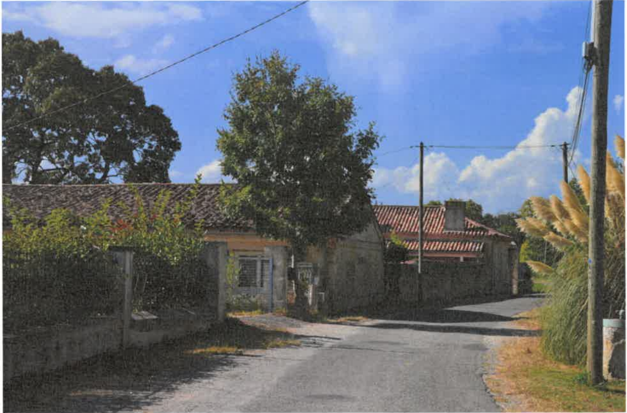
Ancien cuvier et façade latérale du logis, vus depuis la route.
