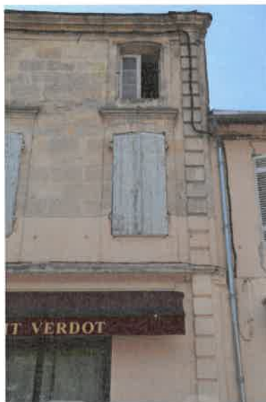
Façade principale (côté place), détail des baies. Phot. Florian Grollimund IVR72_20143304923NUC2A
