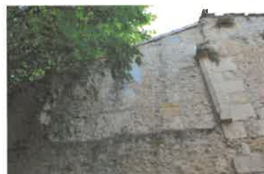
Mur ouest, piédroits de cheminée. Phot. Florian Grollimund IVR72_20143305178NUC2A
