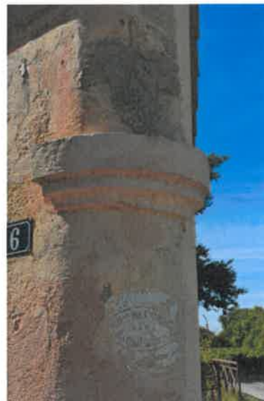
Pilier d'entrée. Phot. Florian Grollimund IVR72_20143306182NUC2A
