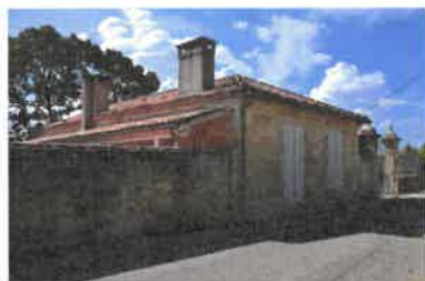
Façade latérale, côté route. Phot. Florian Grollimund IVR72_20143306657NUC2A
