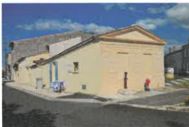
Pignon et élévation nord. Phot. Florian Grollimund IVR72_20143305066NUC2A
