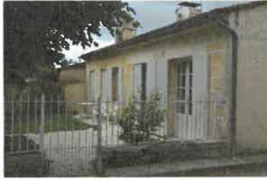
Façade principale, sur jardin. Phot. Florian Grollmund IVR72_20143302888NUC2A
