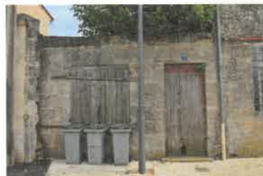
Façade postérieure, entrée d'un ancien chai (?). Phot. Florian Grollmund IVR72_20143305043NUC2A
