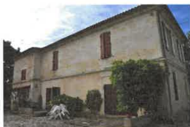
Façade sur cour. Phot. Florian Grollimund IVR72_20143306163NUC2A
