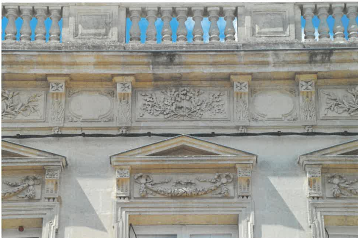
Façade principale, détail du décor.
