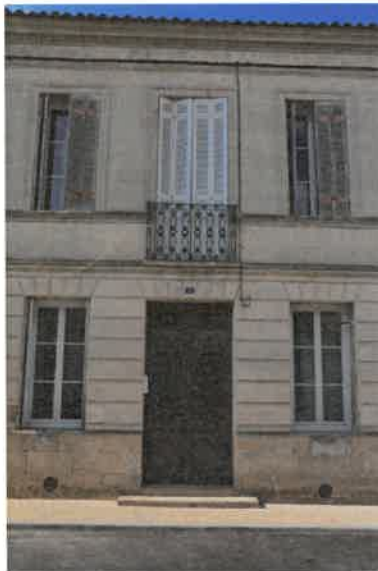
Travée centrale. Phot. Claire Steimer IVR72_20143305026NUC2A
