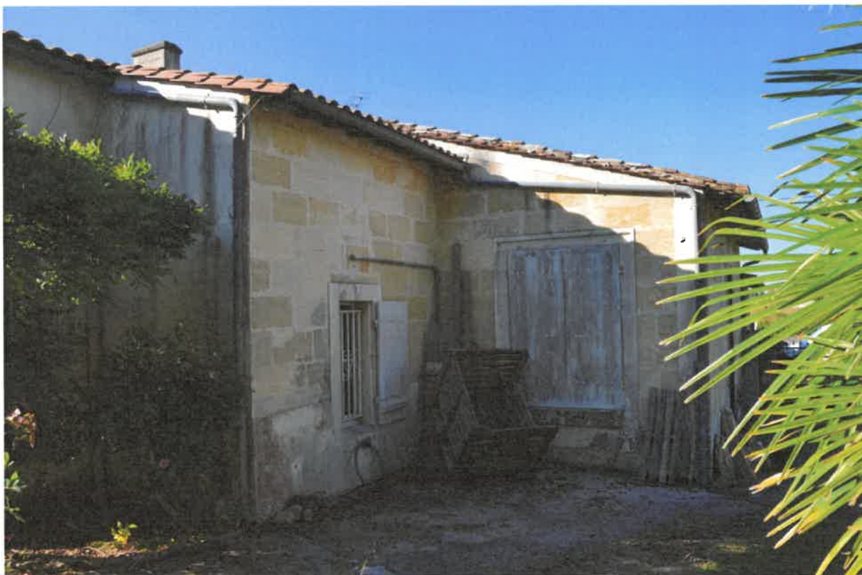
Façade nord, cuvier : baie de décharge.
