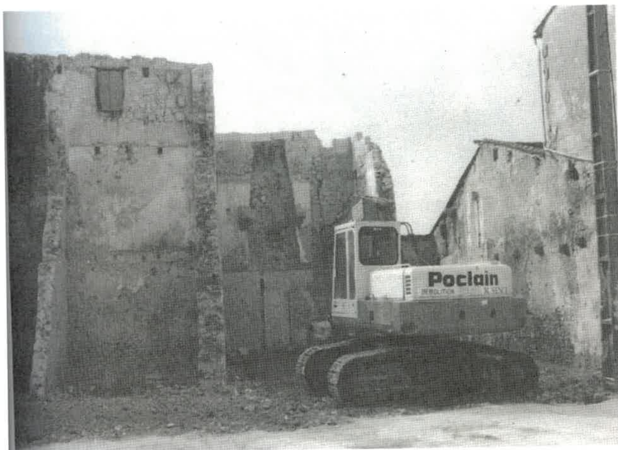
Vue des travaux de destruction, 1998.
