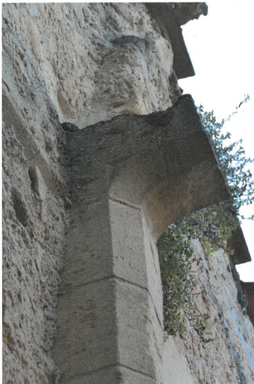
Mur ouest, détail de moulure du piédroit de cheminée.
