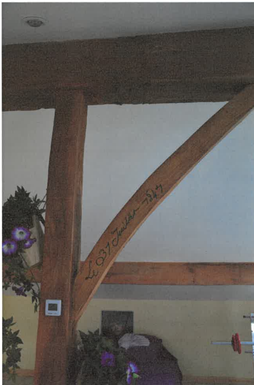
Charpente, détail de l'inscription.
