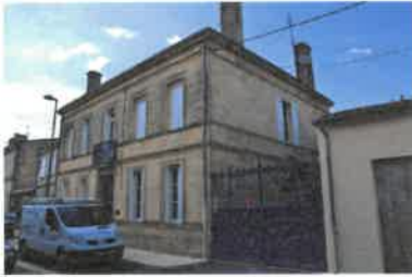
Vue d'ensemble. Phot. Claire Steimer IVR72_20143305023NUC2A
