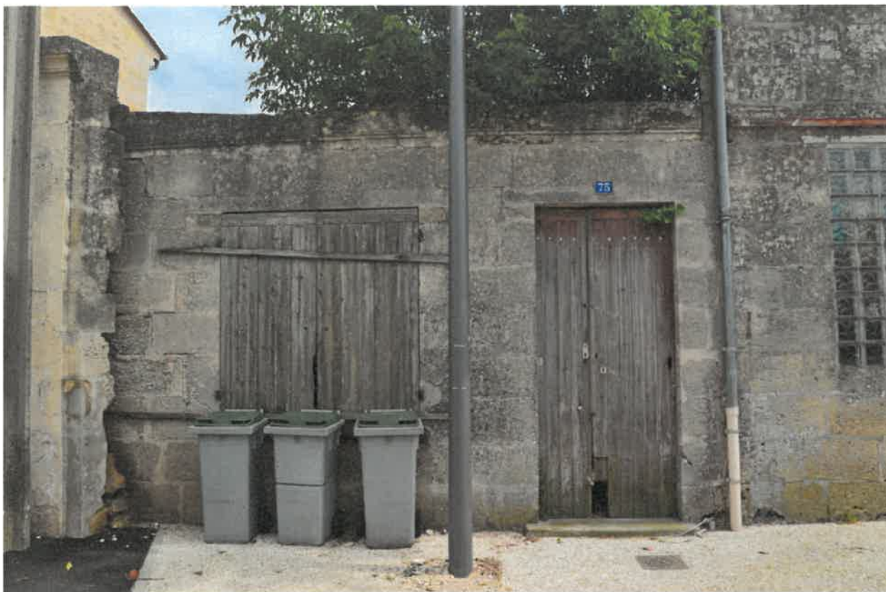
Façade postérieure, entrée d'un ancien chai (?).
