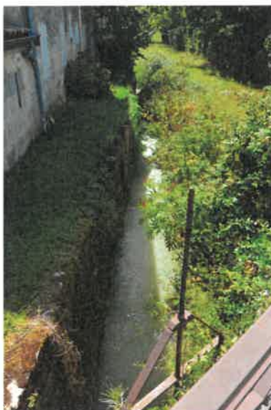
Fossé en eau équipé d'une vanne avec pelle. Phot. Florian Grollimund IVR72_20143306180NUC2A
