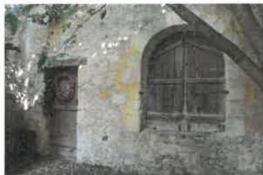
Mur sud, baie de décharge (?). Phot. Florian Grollimund IVR72_20143305179NUC2A
