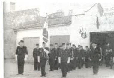
Vue de l'ancienne caserne, avant 1971. Phot. Roger Dulas IVR72_20143305175NUC1
