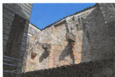
Ancienne salle (?) : cheminée, placard. Phot. Florian Grollimund IVR72_20143305176NUC2A
