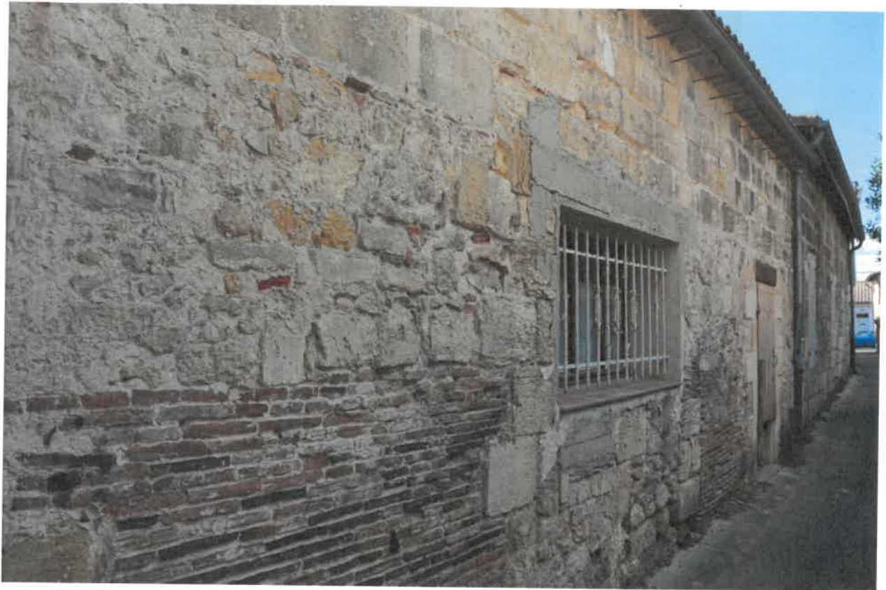
Élévation postérieure sur ruelle, ancien chai (?).
