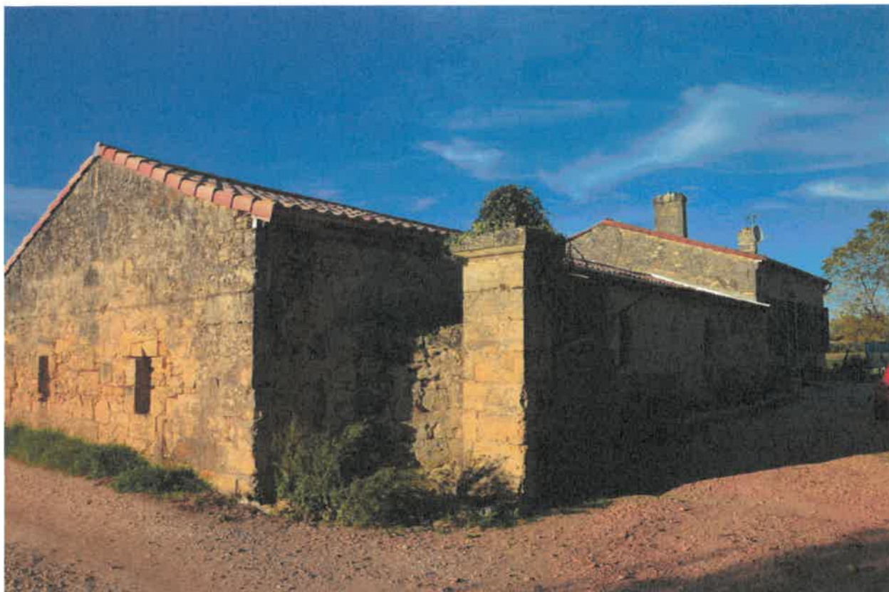
Vue d'ensemble : façades sur cour.
