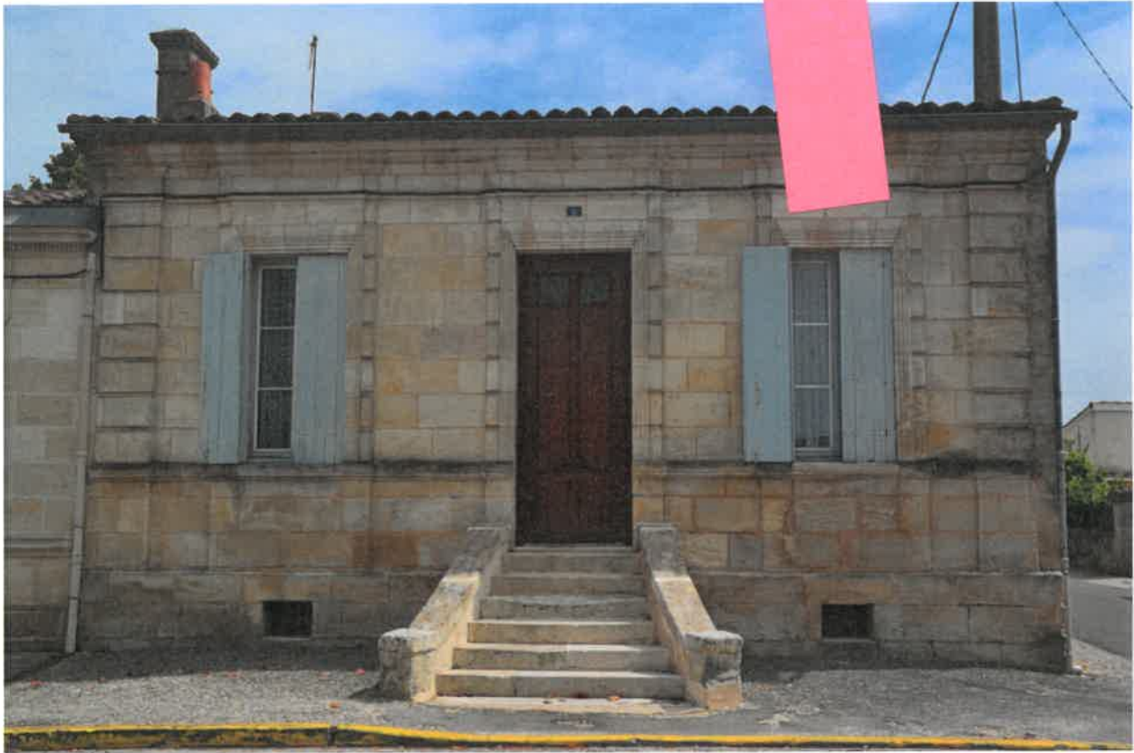
Deuxième bloc, façade.
