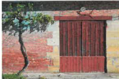
Dépendance en brique. Phot. Florian Grollimund IVR72_20143302854NUC2A
