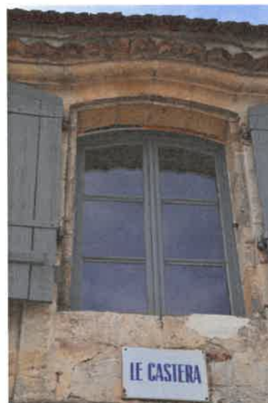
Pavillon central, fenêtre haute. Phot. Florian Grollimund IVR72_20143304818NUC2A
