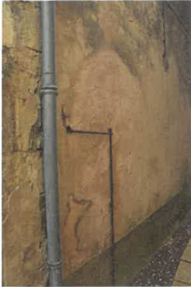
Gouttereau ouest, porte basse en arc brisé (?). Phot. Florian Grollimund IVR72_20143305092NUC2A
