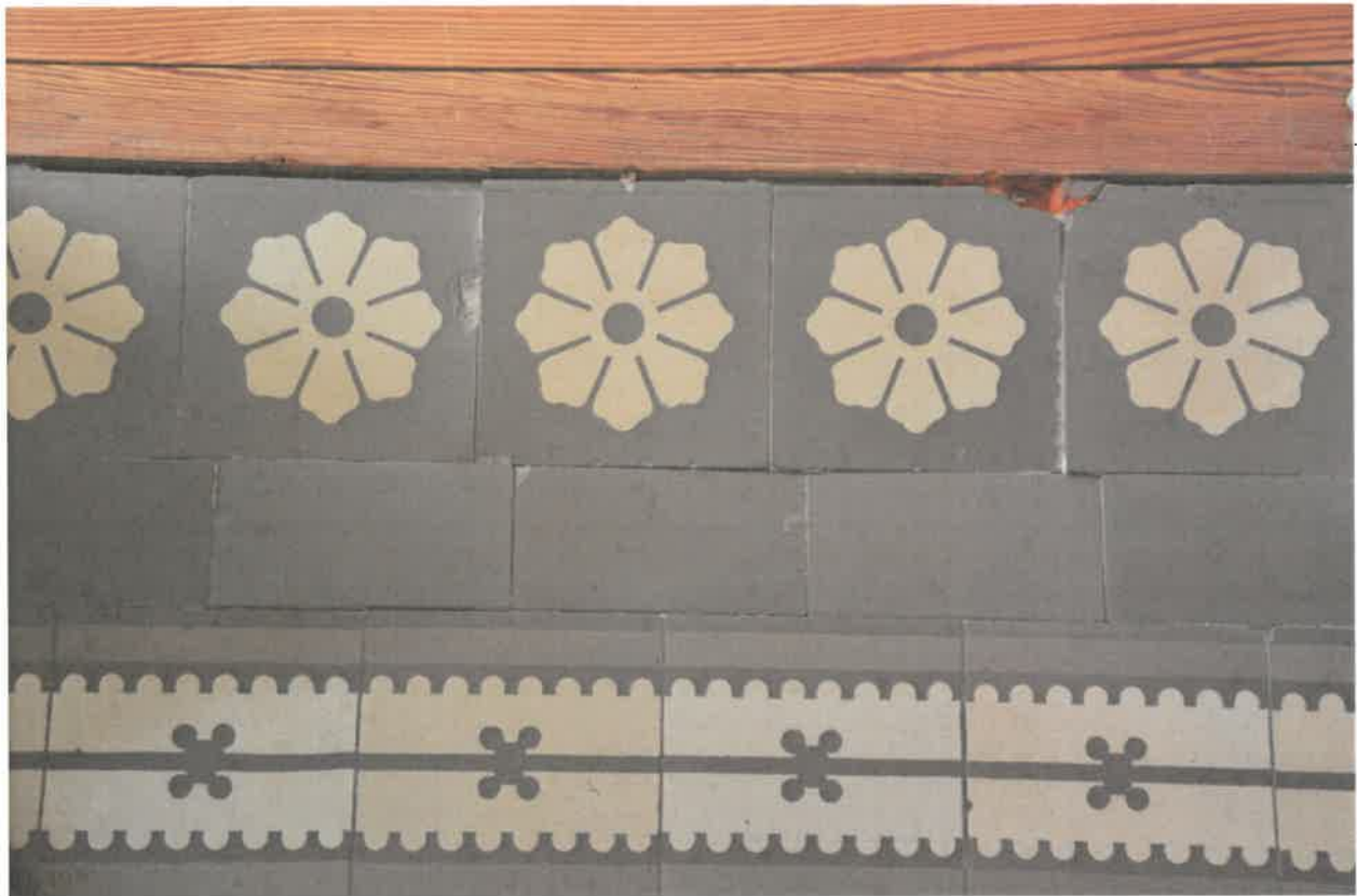
Intérieur, détail des carreaux du vestibule.
