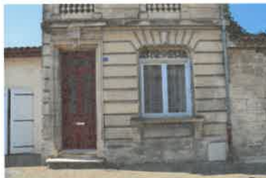
Façade principale, rez-de-chaussée. Phot. Florian Grollmund IVR72_20143305056NUC2A
