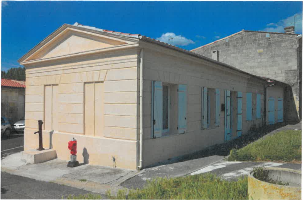
Pignon et élévation sud.
