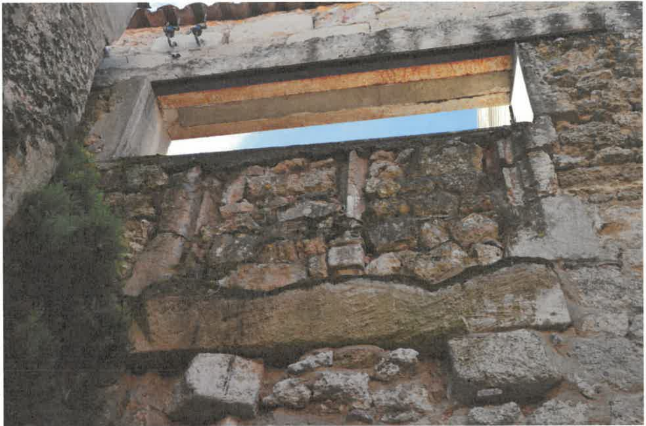
Croisée à listel, vue générale.
