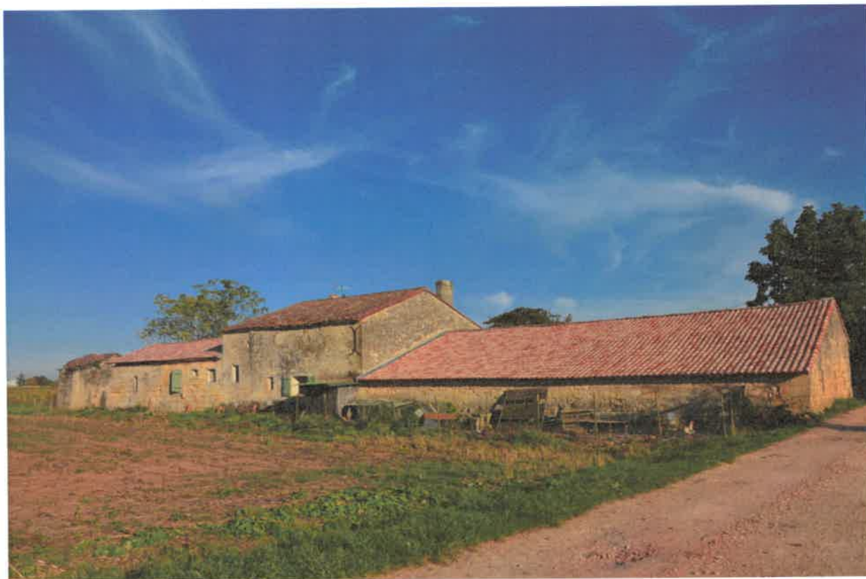
Vue d'ensemble : façades postérieures.
