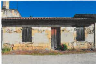
Deuxième logis, façade principale. Phot. Florian Grollimund IVR72_20143302856NUC2A
