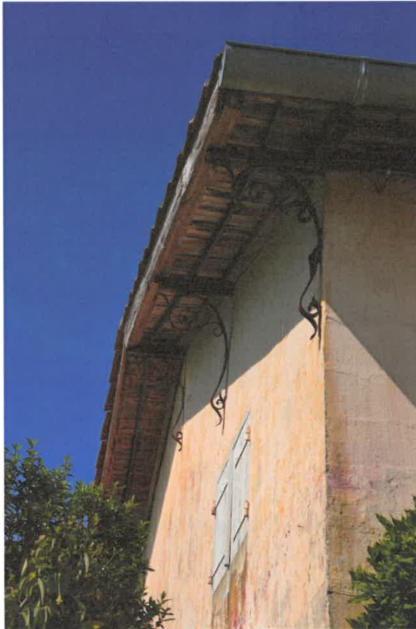
Pignon et structure métallique.
