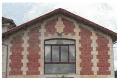
Cuvier : pignon en brique avec porte haute. Phot. Adrienne Barroche IVR72_20143310059NUC4A
