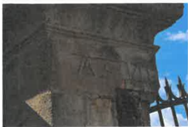
Portail : pilier gauche, détail. Phot. Florian Grollimund IVR72_20143306659NUC2A
