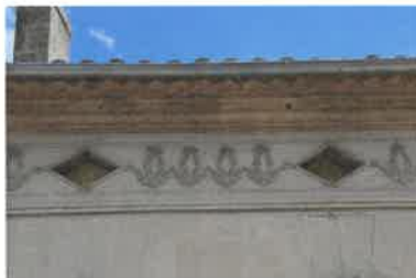
Corniche et surcroît. Phot. Claire Steimer IVR72_20143304968NUC2A
