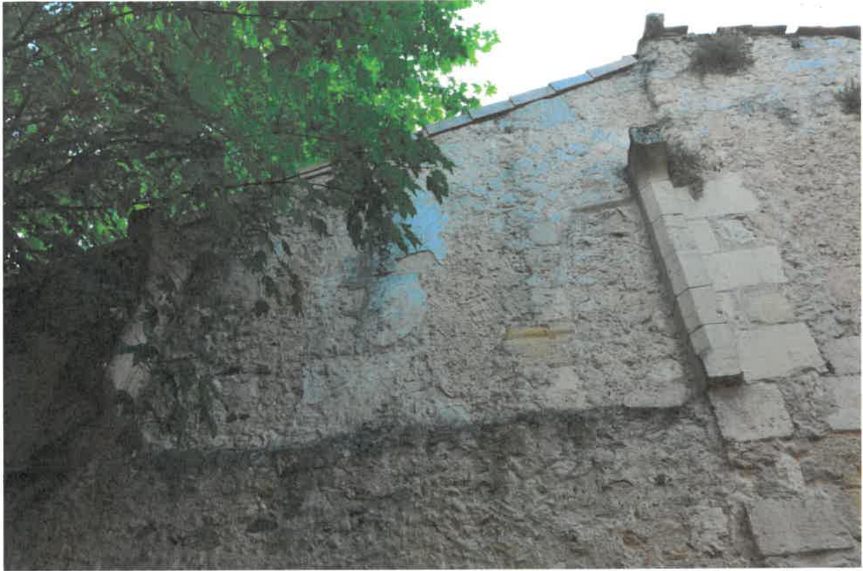
Mur ouest, piédroits de cheminée.
