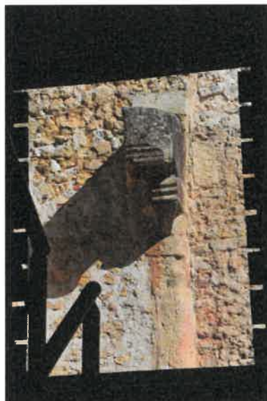
Cheminée, détail d'un corbeau mouluré. Vue depuis la cage d'escalier. Phot. Florian Grollimund IVR72_20143305186NUC2A
