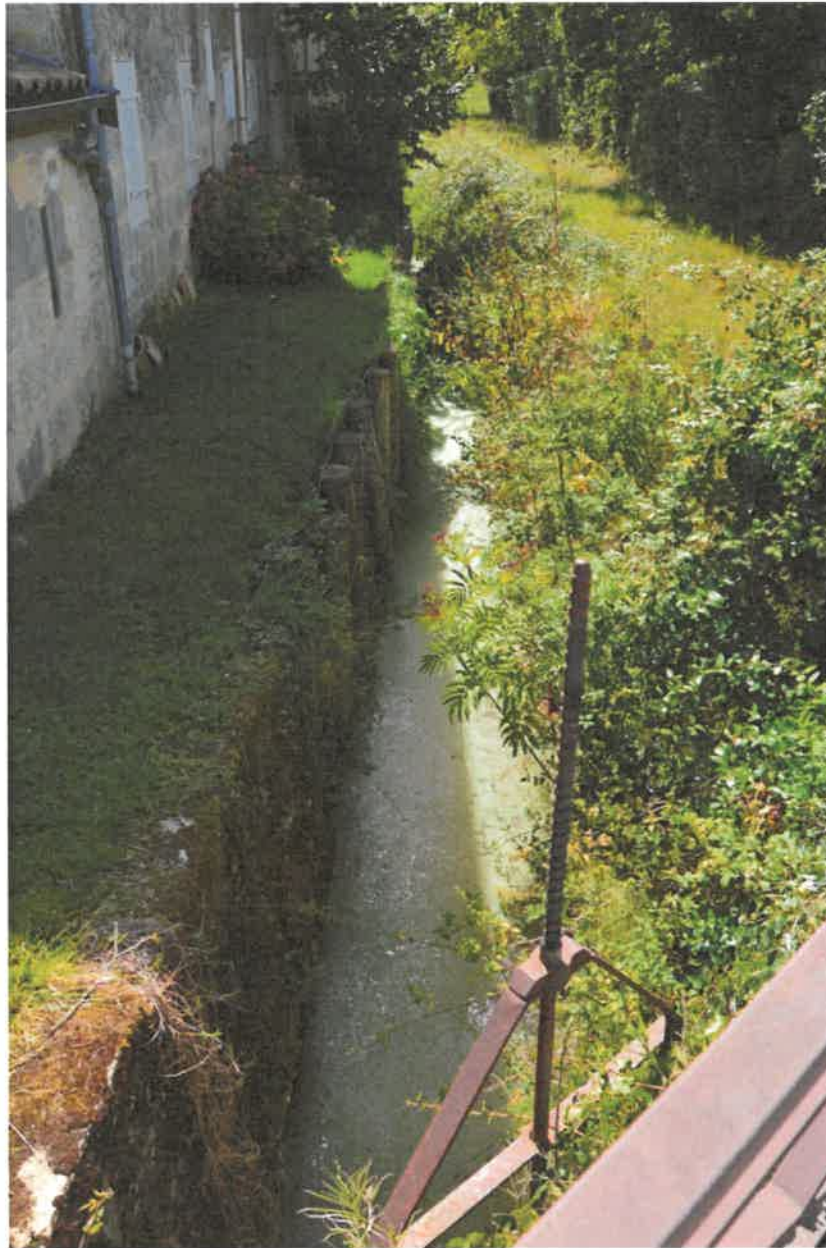
Fossé en eau équipé d'une vanne avec pelle.
