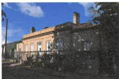
Façade sur rue. Phot. Florian Grollimund IVR72_20143302991NUC2A
