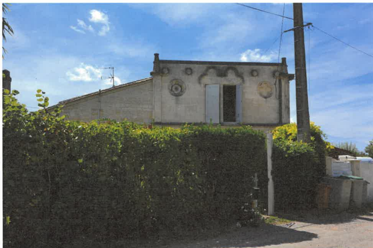
Façade principale, vue depuis le chemin.
