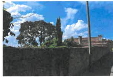
Mur de clôture. Phot. Florian Grollimund IVR72_20143306662NUC2A
