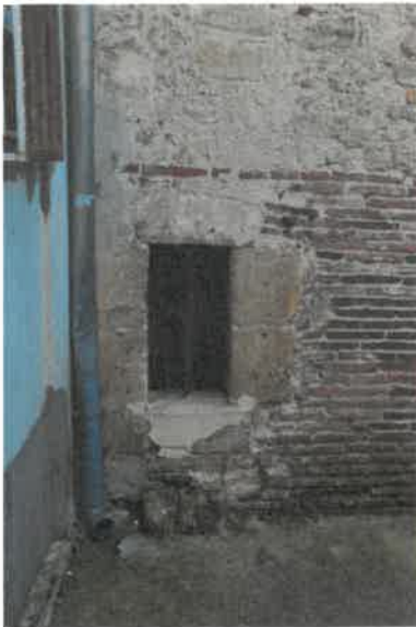
Élévation postérieure sur ruelle, pierre d'évier. Phot. Florian Grollimund IVR72_20143304988NUC2A
