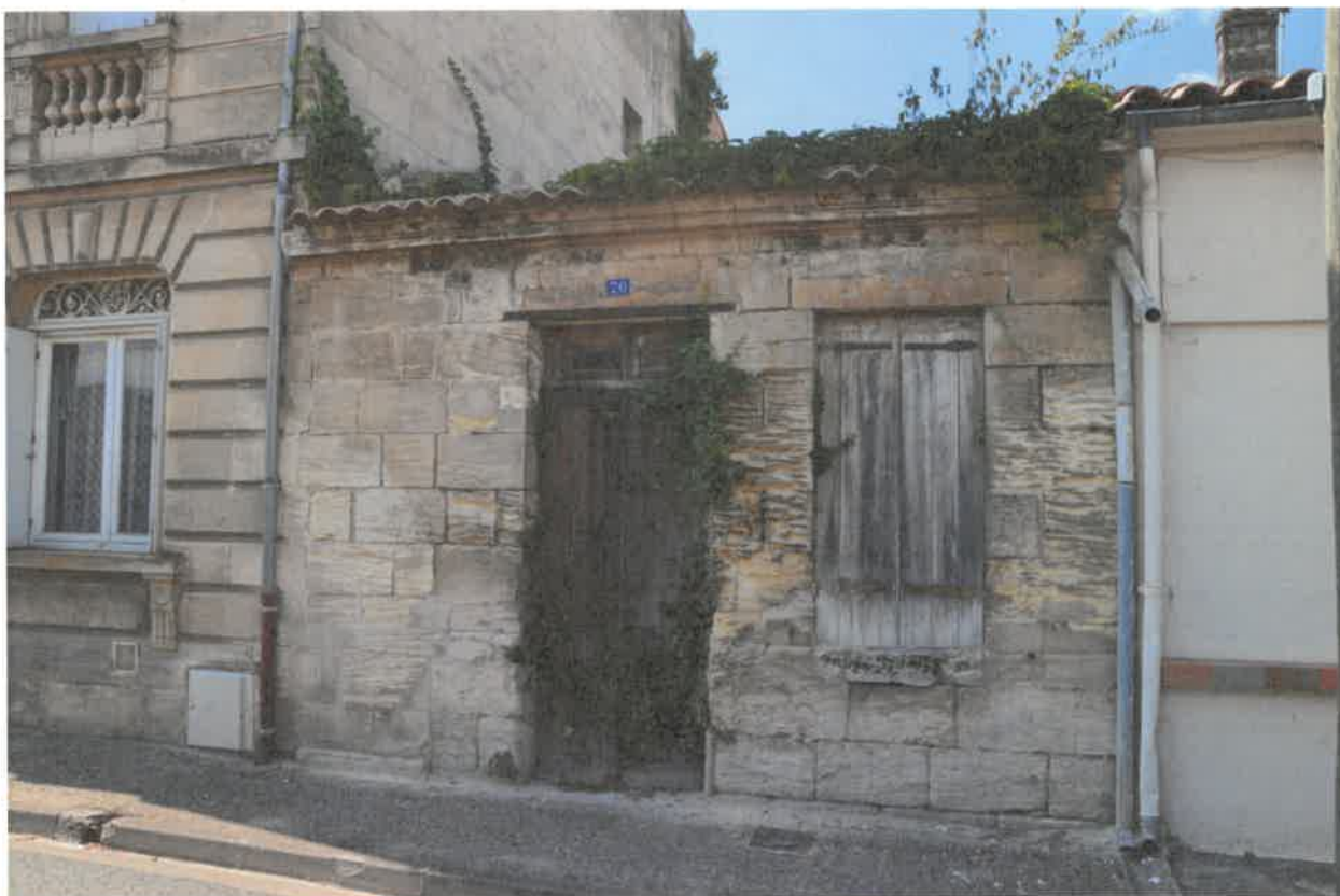
Façade principale, dépendance.
