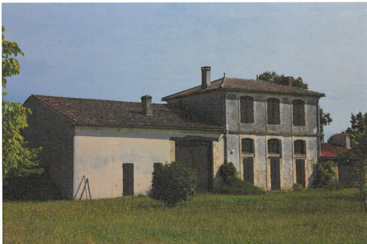
Façade principale (sud).
