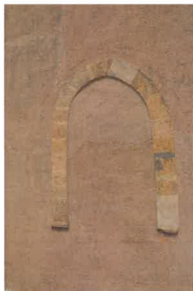
Pignon ouest, baie de décharge (?). Phot. Florian Grollmund IVR72_20143305048NUC2A
