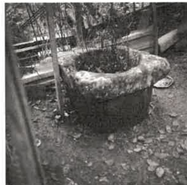
Filtreuse à eau, état en 1976. Phot. Catherine Craveia IVR72_19763303825X
