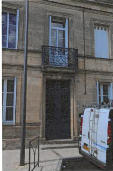
Travée centrale. Phot. Claire Steimer IVR72_20143305022NUC2A
