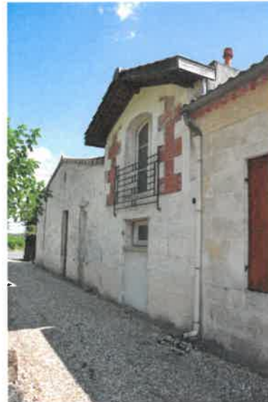
Pignon sur façade nord. Phot. Florian Grollimund IVR72_20143304806NUC2A
