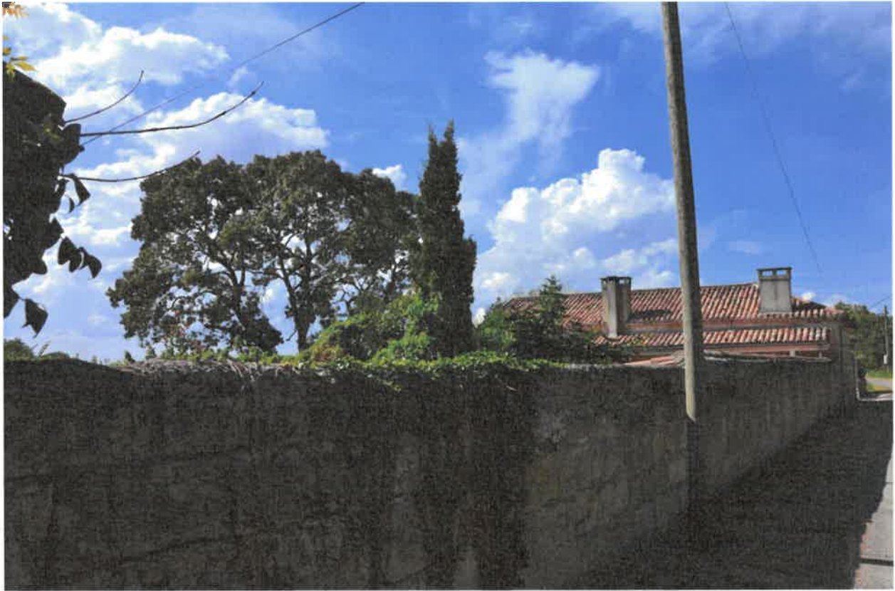
Mur de clôture.
