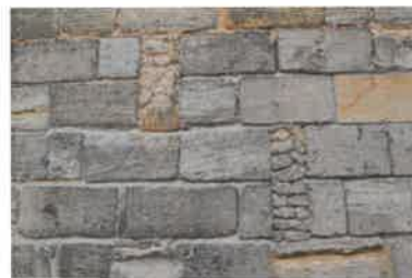
Jours d'aération obturés d'un ancien chai (?). Phot. Florian Grollimund IVR72_20143304984NUC2A
