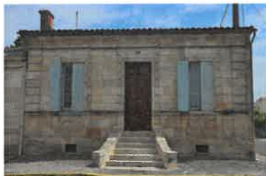
Deuxième bloc, façade. Phot. Florian Grollimund IVR72_20143302930NUC2A
