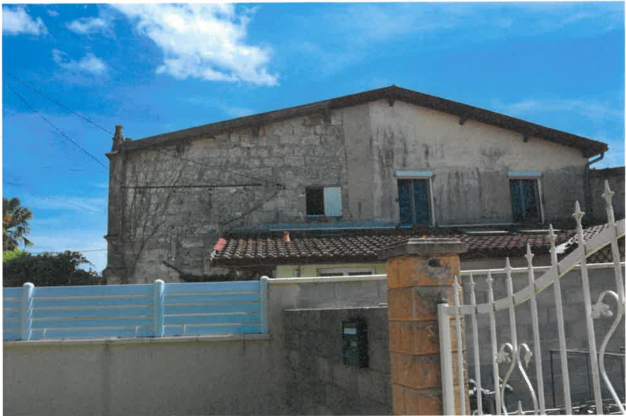
Façade latérale nord.
