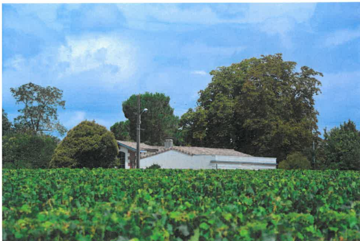
Vue générale depuis les vignes.
