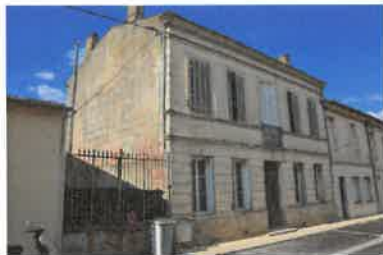
Vue d'ensemble. Phot. Claire Steimer IVR72_20143305025NUC2A
