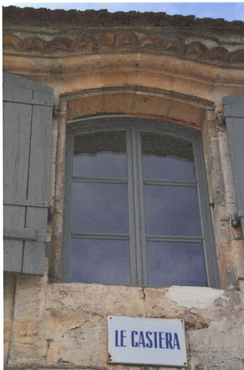
Pavillon central, fenêtre haute.
