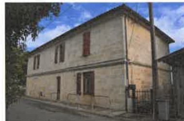
Façade sur route. Phot. Florian Grollimund IVR72_20143306162NUC2A
