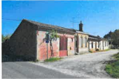
Ensemble, depuis l'ouest. Phot. Florian Grollimund IVR72_20143302853NUC2A
