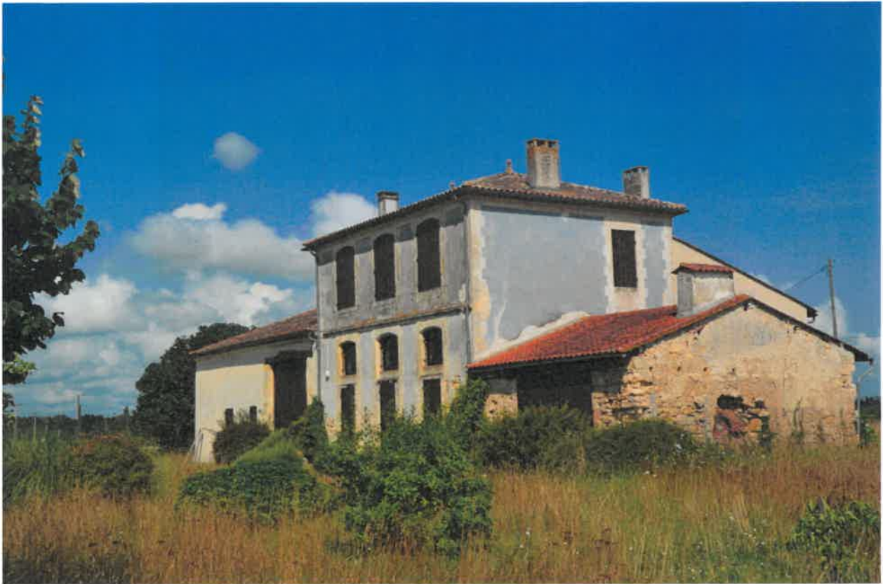
Façades principale et latérale (est).
