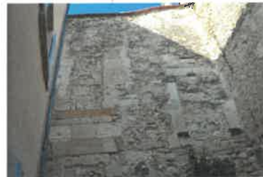
Mur est, ouvertures médiévales/modernes. Phot. Florian Grollimund IVR72_20143305184NUC2A
