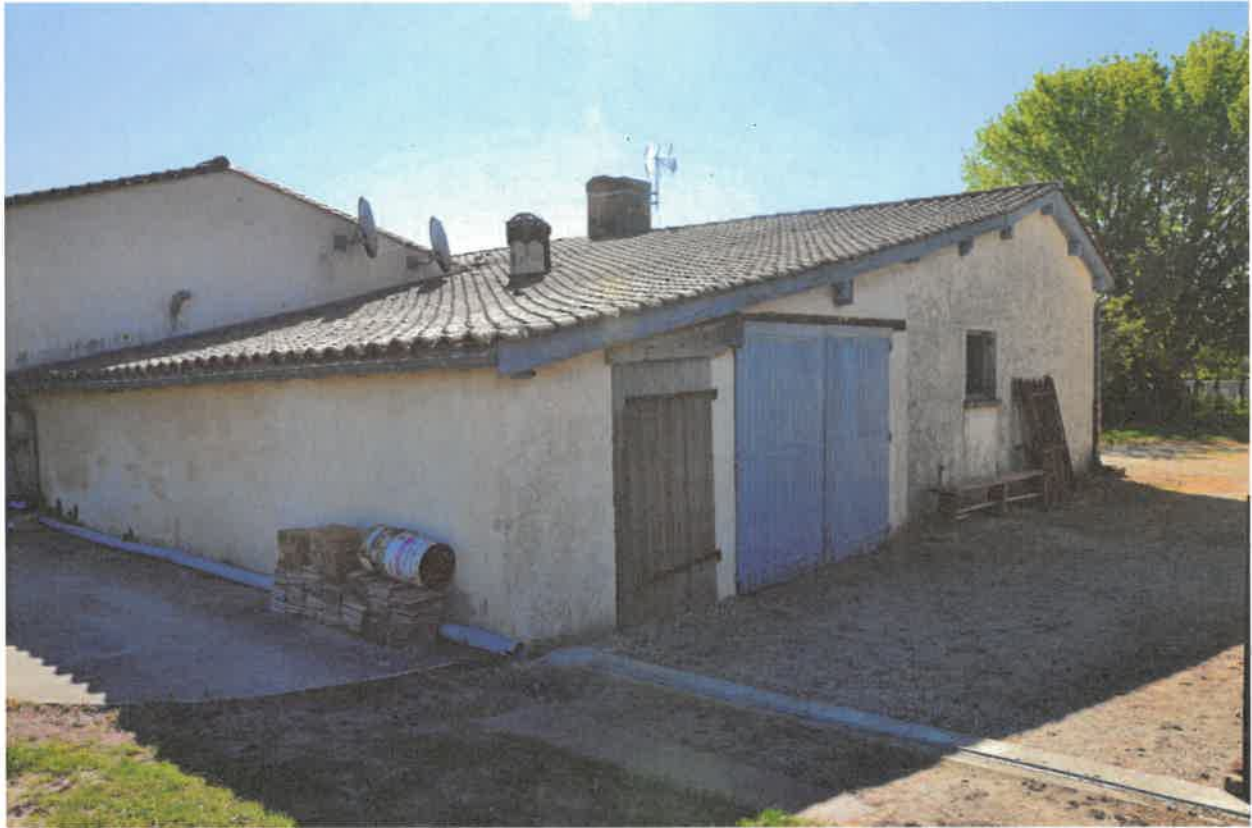
Pignon ouest, dépendance ou ancien chai (?).
