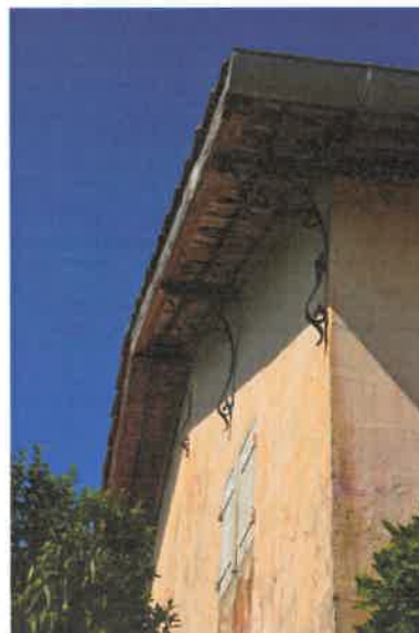
Pignon et structure métallique. Phot. Florian Grollimund IVR72_20143306185NUC2A
