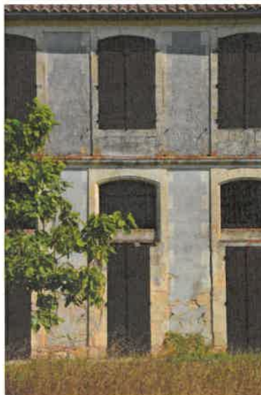
Façade principale, détail des baies. Phot. Florian Grollimund IVR72_20143306779NUC2A
