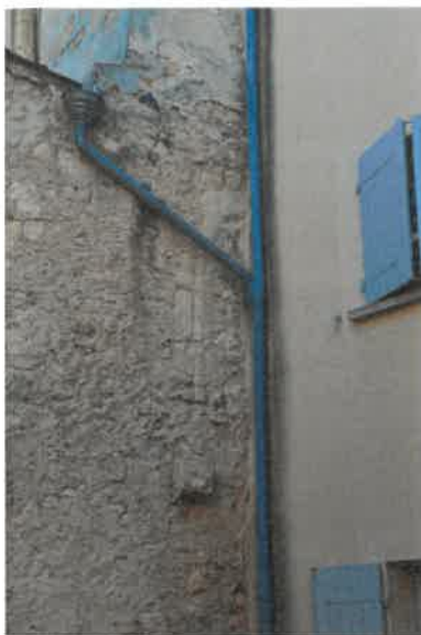
Mur ouest, placage du nouveau bâtiment. Phot. Florian Grollimund IVR72_20143305182NUC2A
