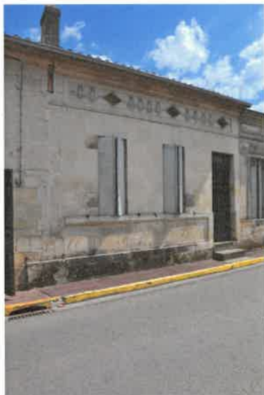
Vue d'ensemble. Phot. Claire Steimer IVR72_20143304967NUC2A
