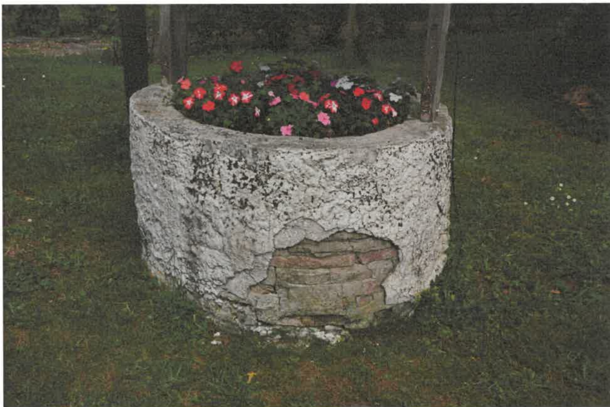
Puits, détail de la maçonnerie.
