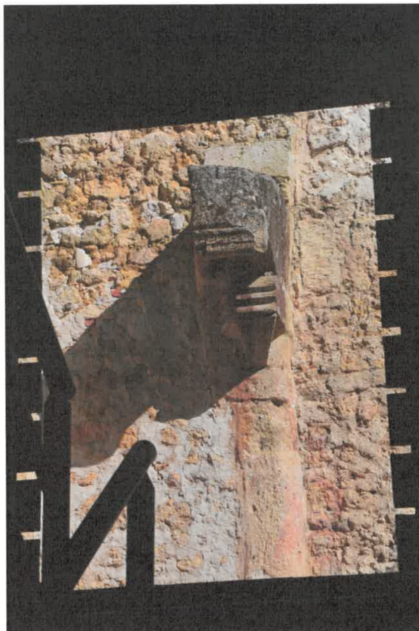
Cheminée, détail d'un corbeau mouluré. Vue depuis la cage d'escalier.
