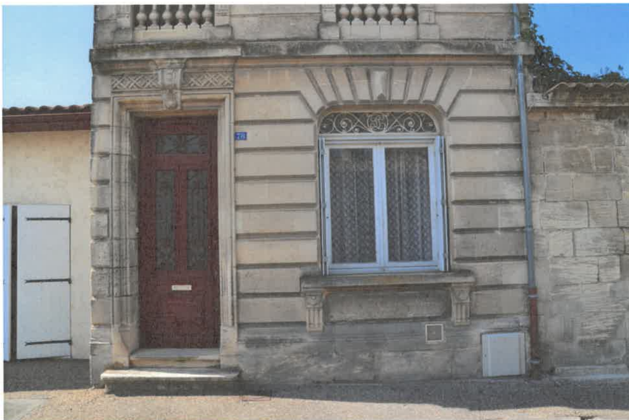
Façade principale, rez-de-chaussée.
