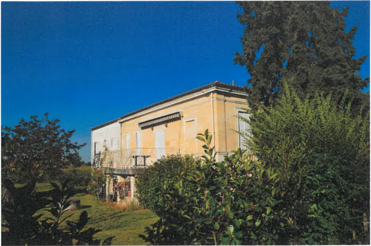
Façade latérale sud.
