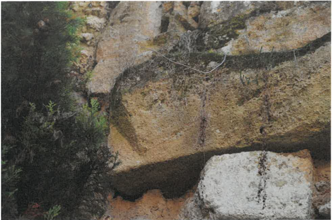
Croisée à listel, détail de l'appui.
