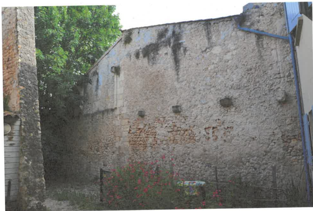
Mur ouest, vue d'ensemble.
