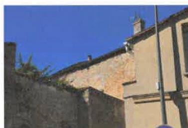
Gouttereau est, vestiges d'une fenêtre à meneau simple. Phot. Florian Grollimund IVR72_20143305090NUC2A
