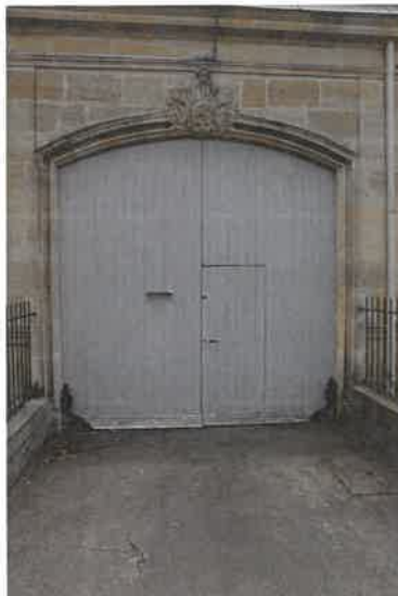
Porte cochère. Phot. Florian Grollimund IVR72_20143302926NUC2A
