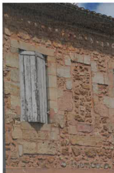
Façade sur rue, détail des baies. Phot. Florian Grollimund IVR72_20143304926NUC2A
