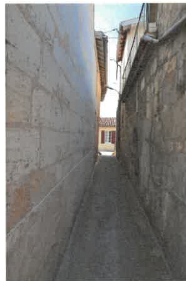
Pignon est et ruelle. Phot. Florian Grollmund IVR72_20143305020NUC2A
