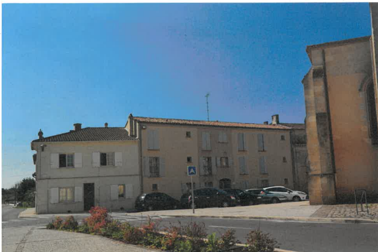
Vue d'ensemble du bâtiment construit en 2000.
