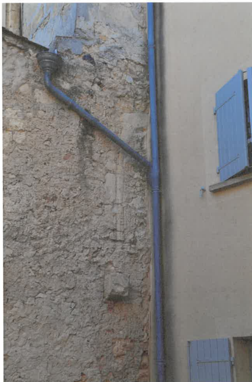
Mur ouest, placage du nouveau bâtiment.
