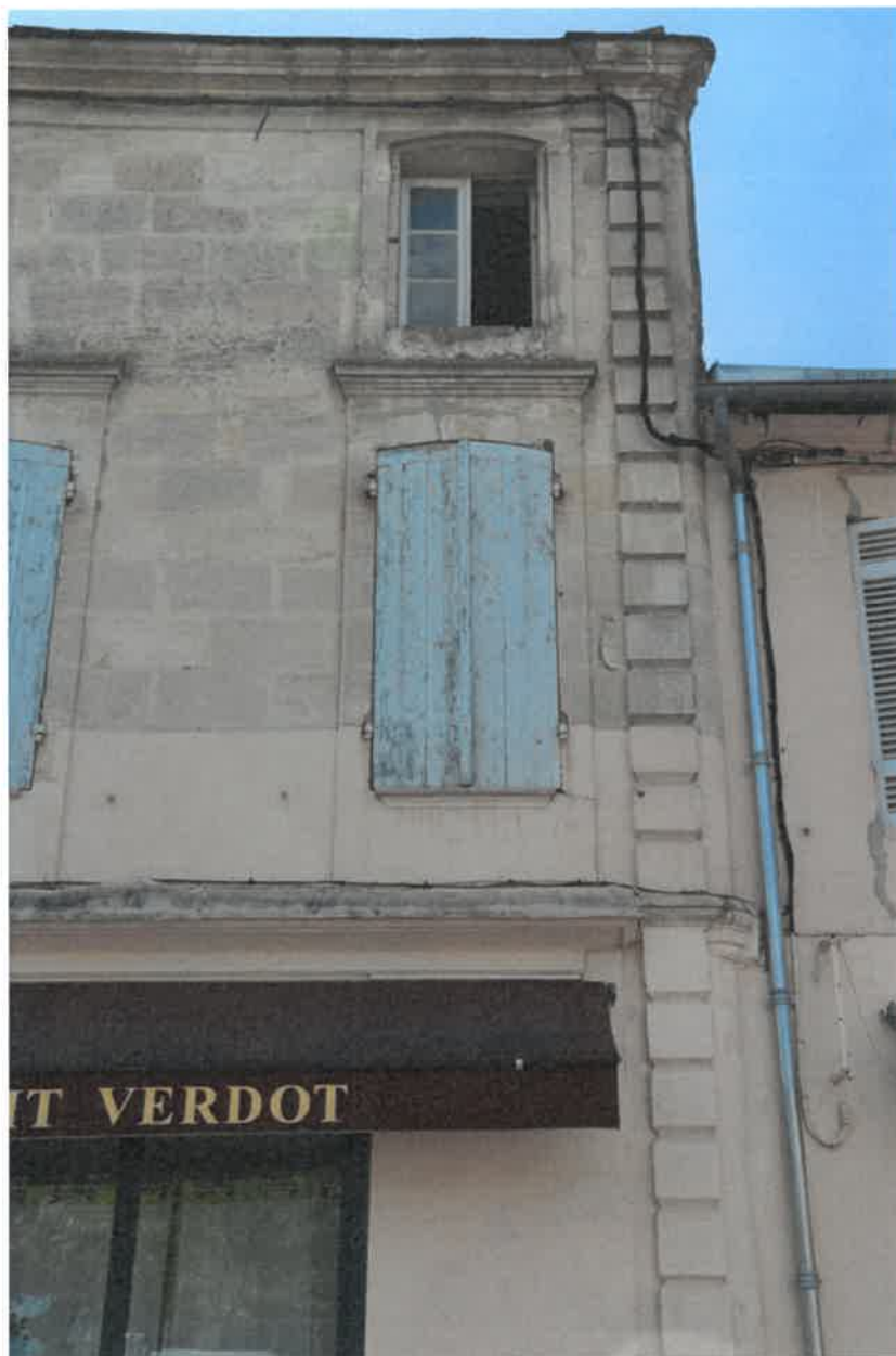
Façade principale (côté place), détail des baies.
