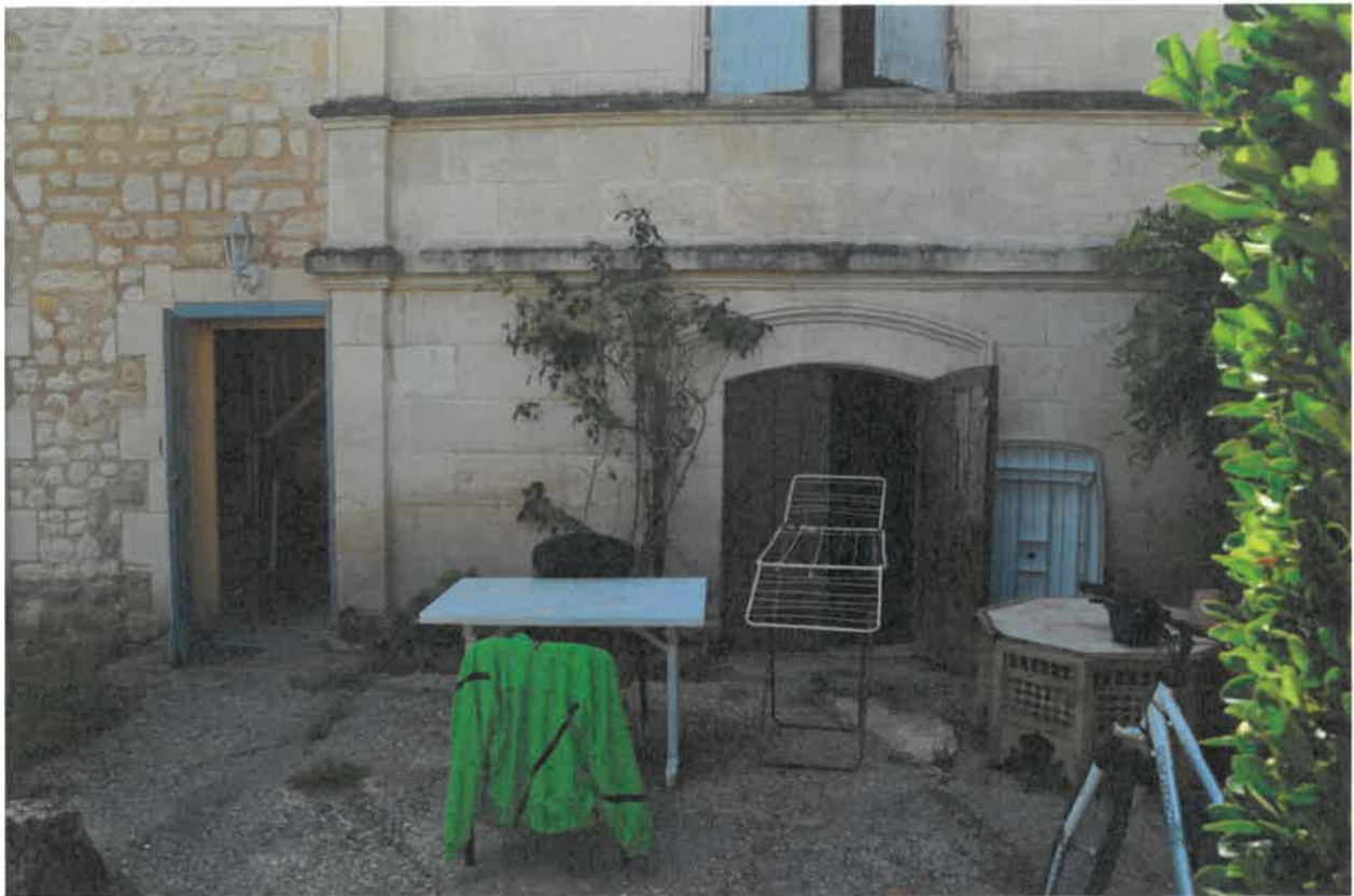
Façade principale, rez-de-chaussée.
