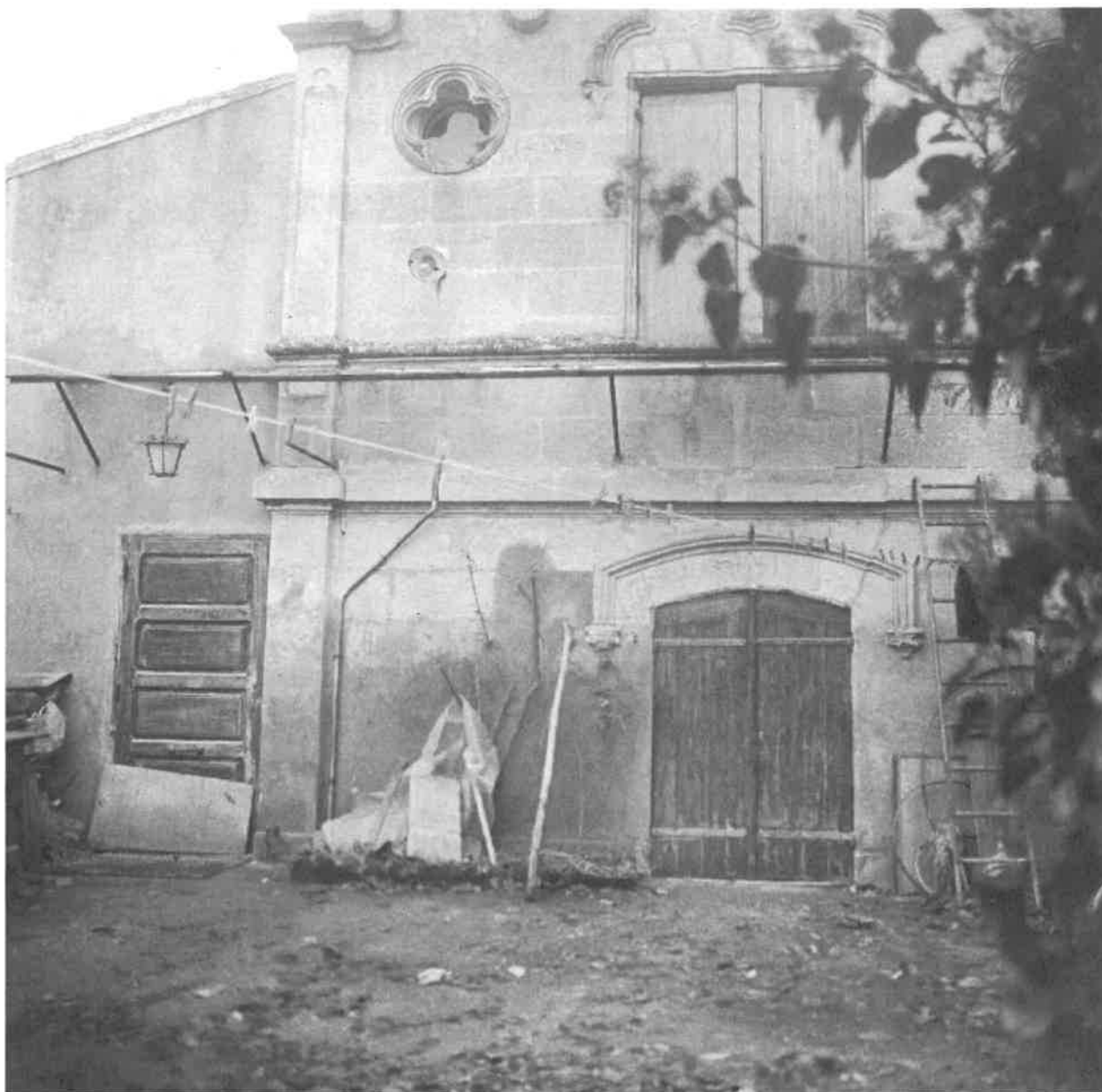
Façade principale, porte du rez-de-chaussée, état en 1976.
