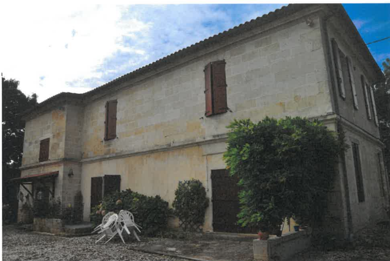
Façade sur cour.
