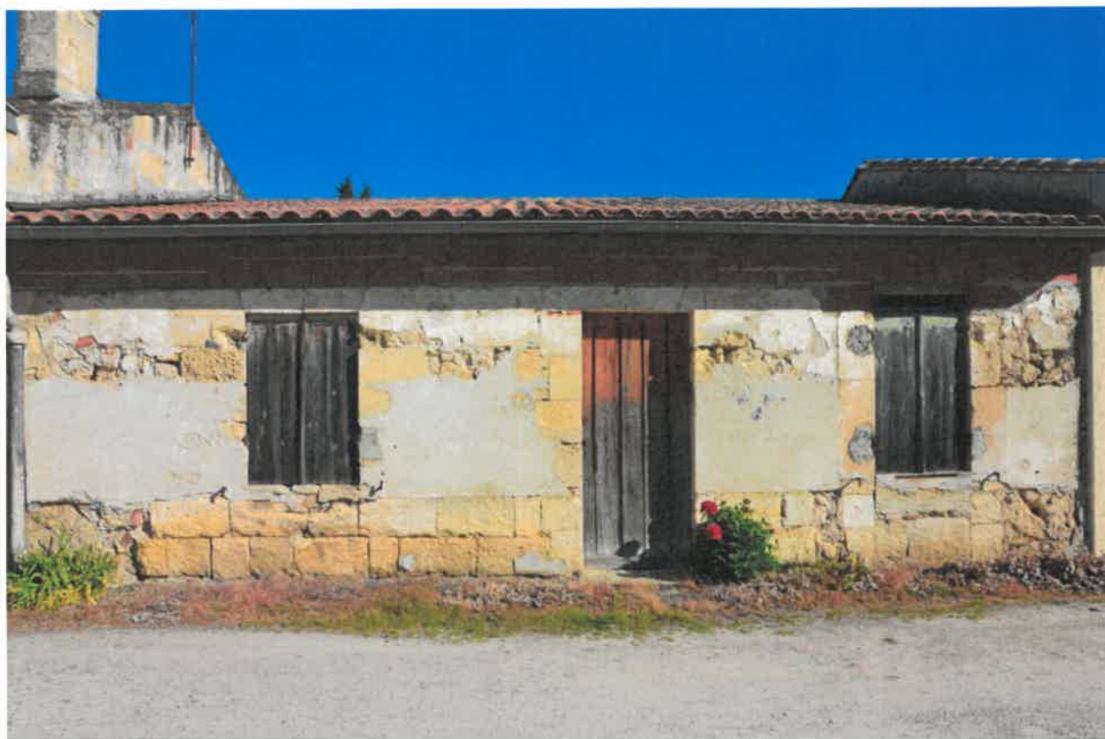
Deuxième logis, façade principale.
