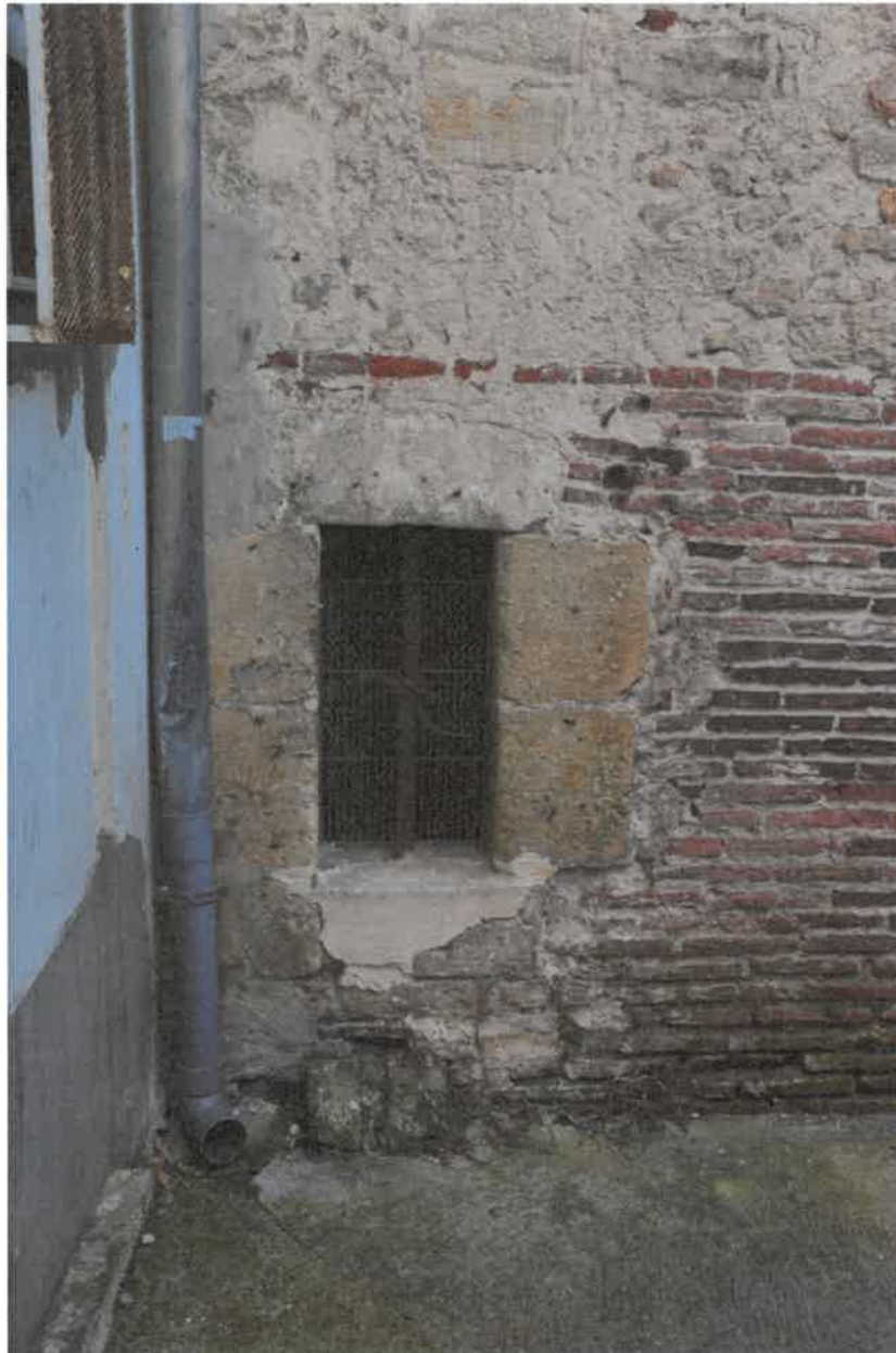
Élévation postérieure sur ruelle, pierre d'évier.
