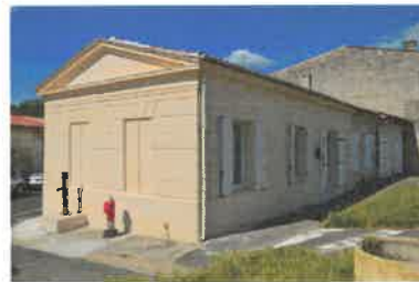
Pignon et élévation sud. Phot. Florian Grollimund IVR72_20143305065NUC2A
