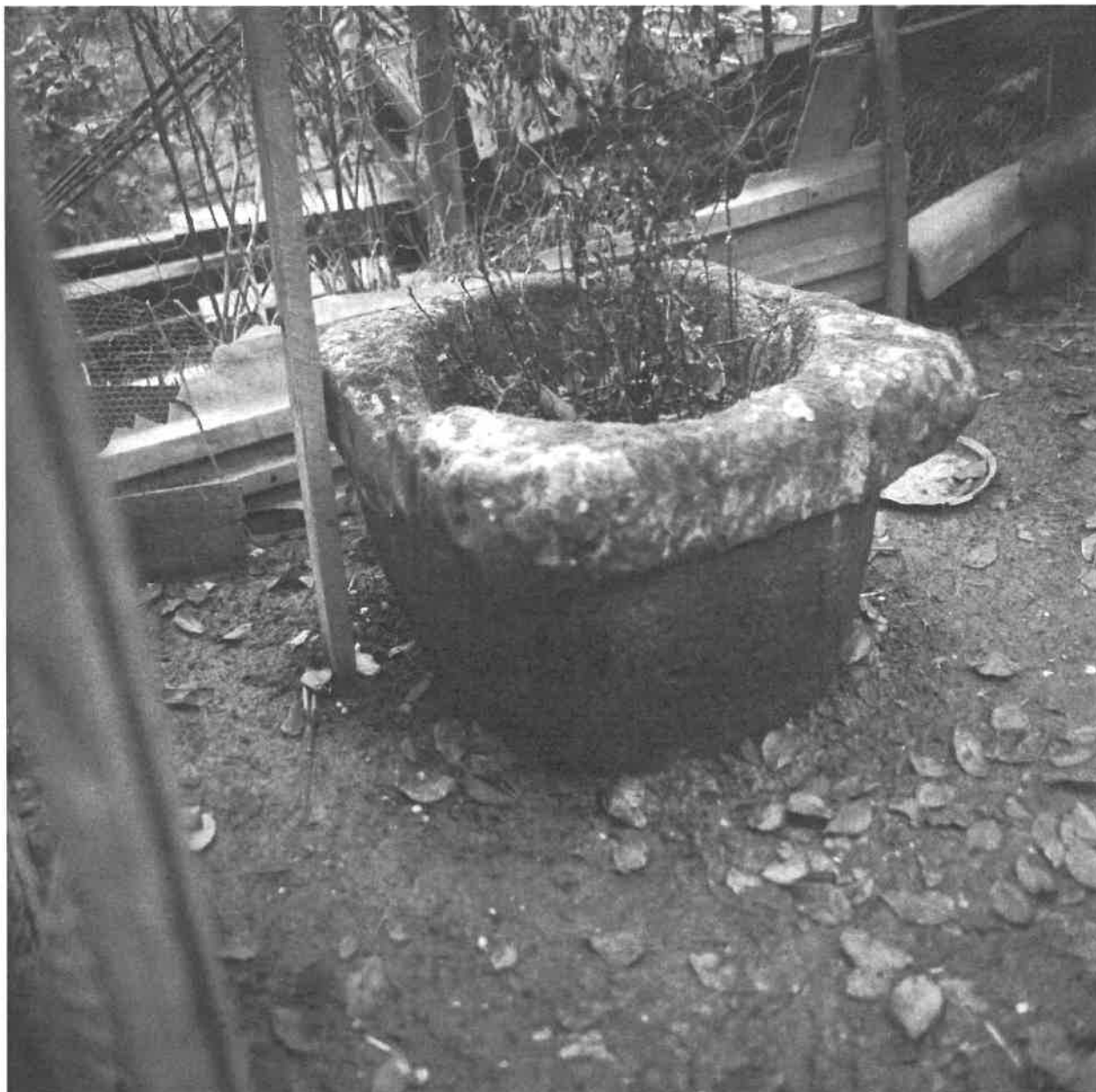
Filtreuse à eau, état en 1976.
