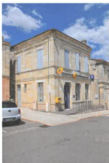
Façade principale. Phot. Claire Steimer
