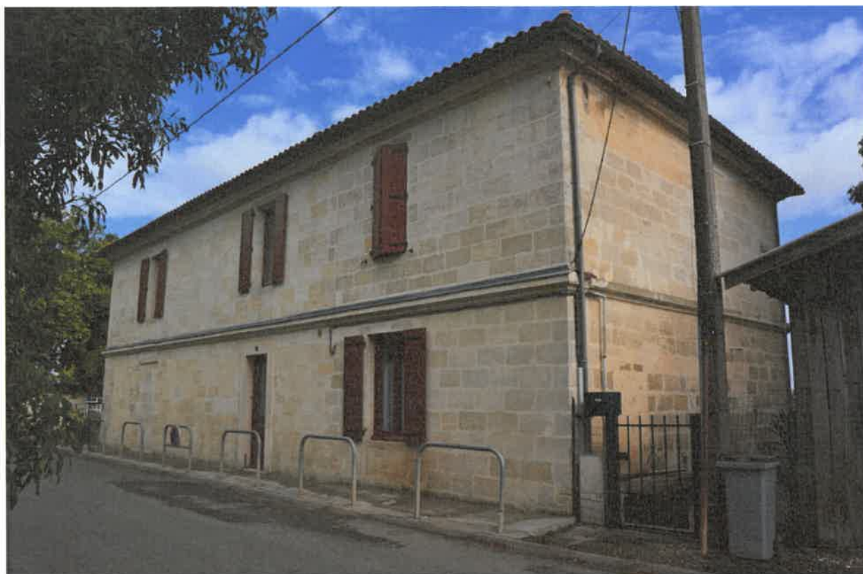
Façade sur route.
