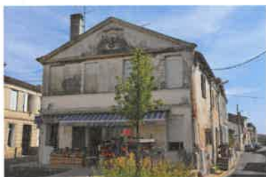
Façade principale sur la place Carnot. Phot. Florian Grollimund IVR72_20143304894NUC2A
