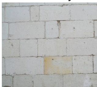
Façade et décors en tuffeau de moellons taillés
