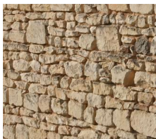
Façade en tuffeau de moellons assisés
