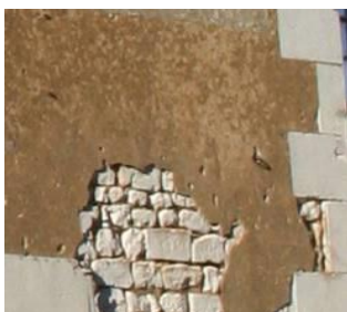
Façade de moellons enduites
