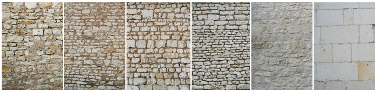
Moellons assisés de tuffeau jaune et blanc
