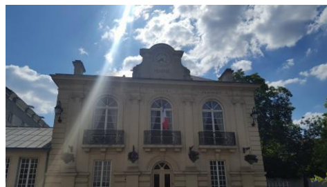
Ancienne Mairie , Bagneux
