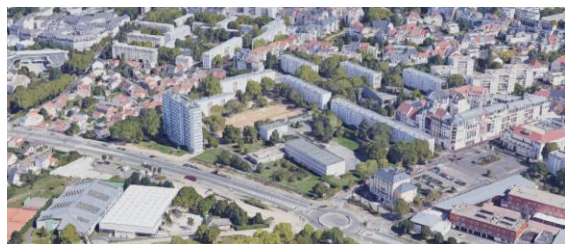
Quartier Ledoux, à proximité d'autres quartiers de grands ensembles, en bordure de la D2.
