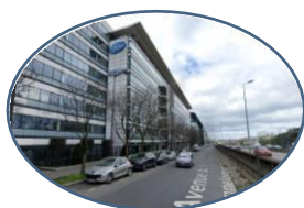
Portion Ouest, occupée par des bureaux. Bâti à l'alignement. Hauteur moyenne : R+10 Absence de mur anti-bruit, proximité immédiate du bd. périphérique.
