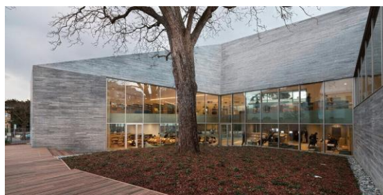
Médiathèque François Villon – Bourg-la-Reine Source : google image
