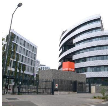
Les Arues, campus Orange Gardens Châtillon
