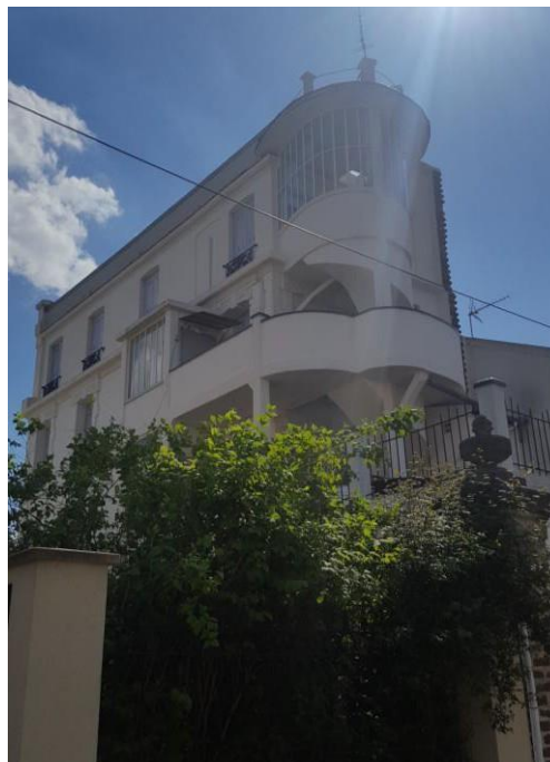
Maison rue Robert Pontet Fin XIXème siècle, reconnaissable par les arcs plats moulurées des fenêtres. Escalier et belvédère en béton des années 30
