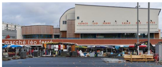
Source: Place Léo Ferré – Commune de Bagneux
