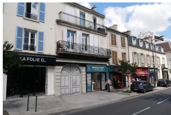
Avenue du Général Leclerc – Espace Ville
