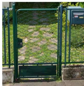
Modèles originaux de portail et de portillon, avec une structure tubulaire similaire aux gardes corps, et majoritairement à claire-voie avec un fin grillage
