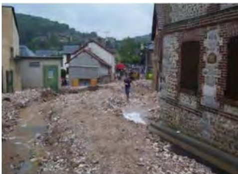
Ruissellements à Saint-Aubin-Epinay le 16 juillet 2007
