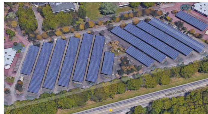
Vue aérienne des ombrières photovoltaïques de l'usine Renault de Cléon (Google Maps)
