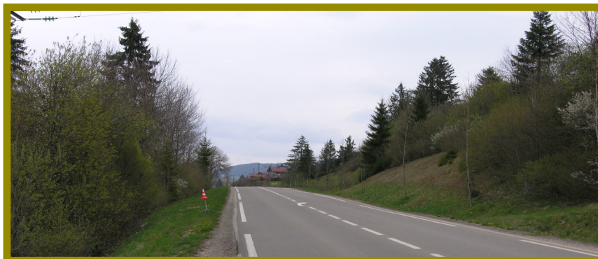
ENTRÉE DEPUIS LABERGEMENT-SAINTE-MARIE
