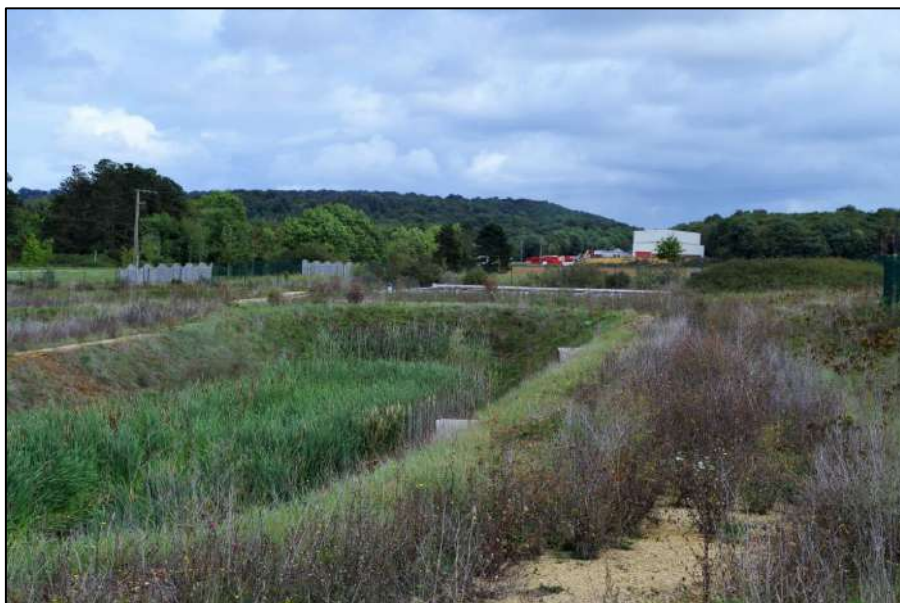
Photographie 66 : Station d'épuration avec filtre d'infiltration de Saizerais
