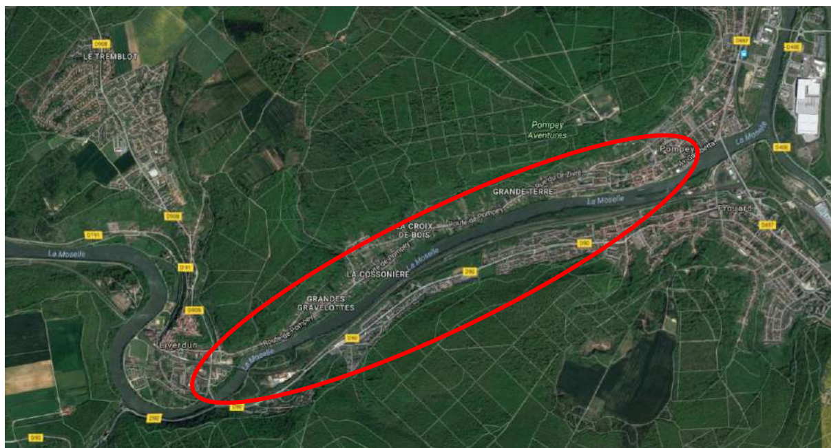
Figure 32 : Exemple d'urbanisation linéaire reliant Liverdun à Pompey et à Frouard de part et d'autre de la Moselle
