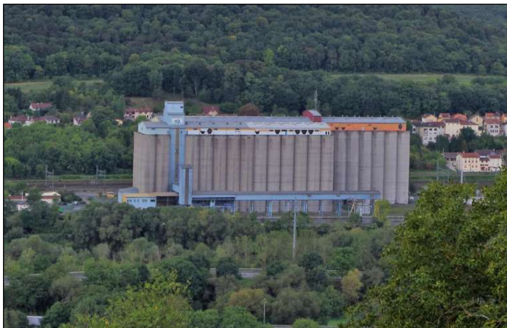
Photographie 16 : Les Silos UCA sur Frouard
