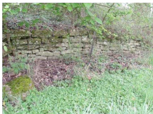
Photo 5 : Muret de pierres sèches
