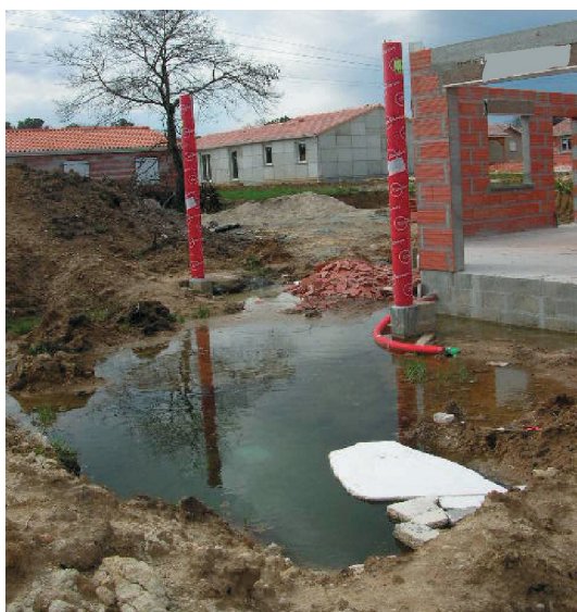
Figure 13 Défaut de gestion des eaux pluviales en phase de construction (Source Socabat)
