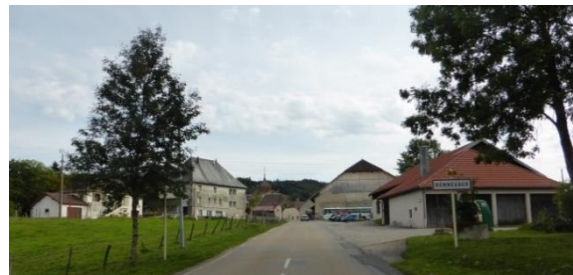
(1) Entrée Nord (RD9) depuis Frasne
