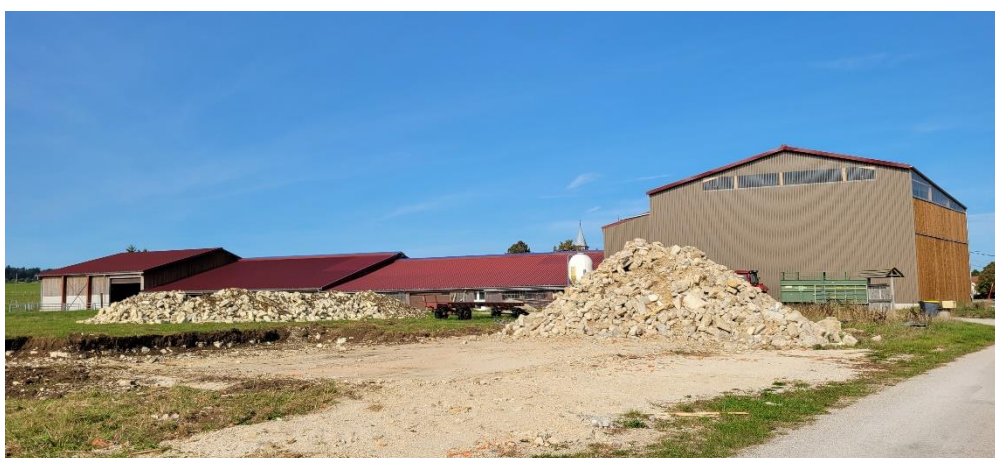
Illustration du bâtiment agricole reconstruit sur la parcelle 123 – photographie IAD novembre 2023.
