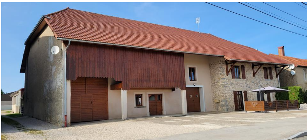
Illustration du bâtiment agricole patrimonial sur la parcelle 93 – photographie IAD novembre 2023.
