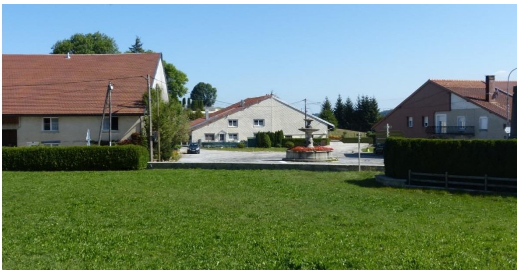
Photo 3 : cœur du village de Boujailles – vue depuis l'école sur la même « place centrale aérée » du village.
