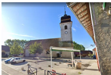
Photo 4 : vue de l'église depuis la rue du Bourg
