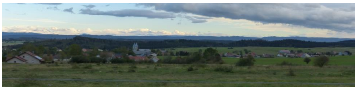
Photo21 : vue depuis le nord du territoire (route de Salins), l'église imprègne la silhouette du village qui apparaît principalement à travers les toitures dans un paysage rural de belle qualité.
