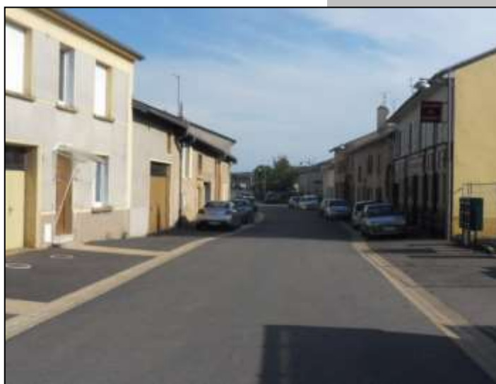
Stationnement sur un trottoir séparé de la voirie par une ligne de couleur et non une rupture en terme de hauteur, rue principale
