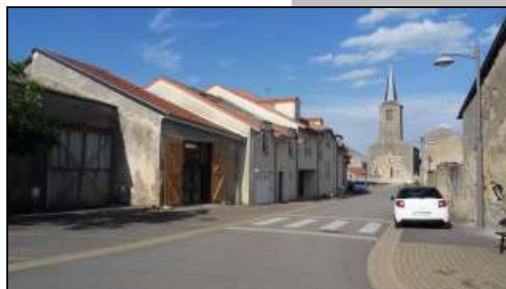
Réhabilitations ayant conservées une harmonie avec les caractéristiques architecturales traditionnelles lorraines
