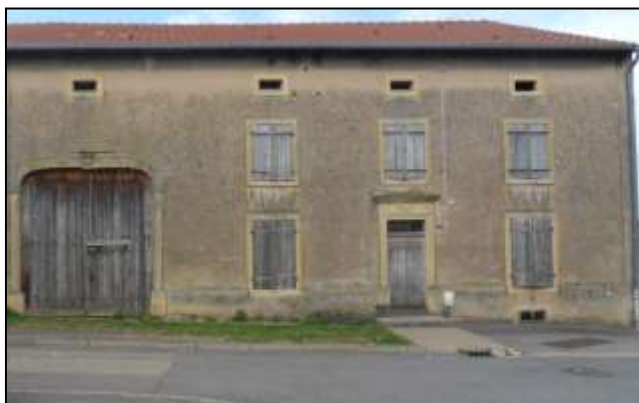
Construction à l'intersection chemin du Pignon et rue de l'école : ouverture plus haute que large, encadrement des ouvertures, toiture rouge vieilli,...
