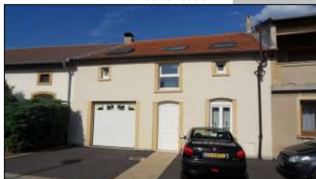
Rénovation respectant globalement les principales caractéristiques architecturales, rue principale
