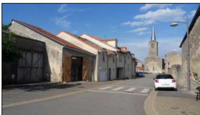
Quelques décrochements de façade et rénovations, rue de l'Eglise
