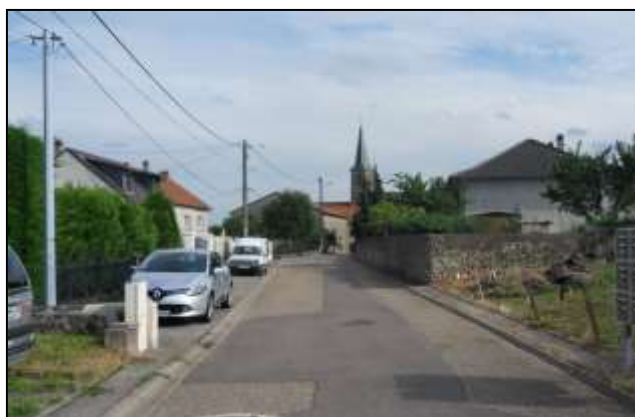
Stationnement sur trottoir non matérialisé au sol dans les lotissements les moins récents, chemin du Pignon
