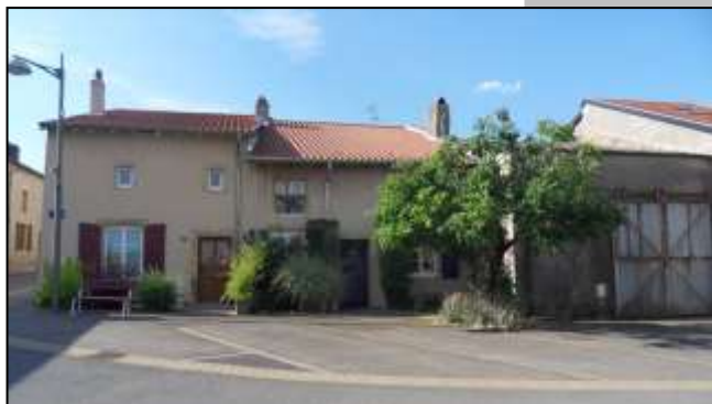
Principales caractéristiques architecturales préservées, rue de l'école
