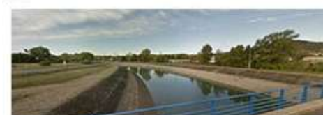
5 Vue du canal Edf et ses berges en direction du Sud depuis le chemin de Liègne sur le pont.
