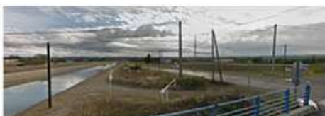
4 Vue du canal EDF depuis le pont. A droite le chemin Georges Simon.
