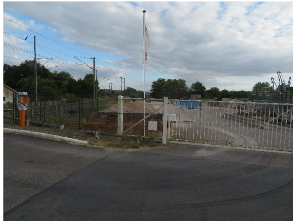
Photo 30. Zone de stockage pour du matériel de construction
