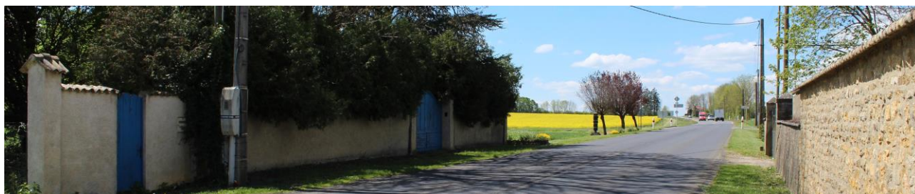
Photo 13. Des murs occultant en sortie de village
