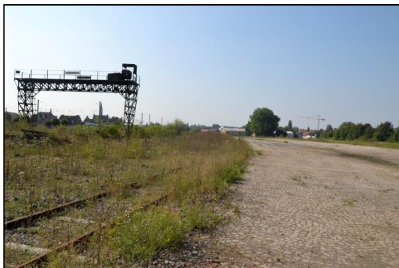
Photo 10. Friche ferroviaire (ALB C)
