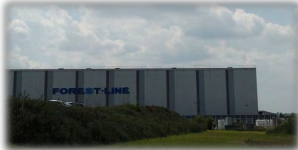
Entreprise Forest Liné Source : Auddicé Environnement
