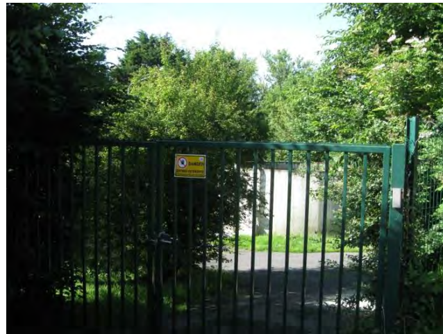
Station d'épuration de Bray-sur-Somme
