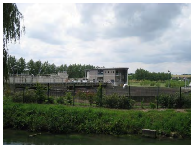
Station d'épuration d'Albert
