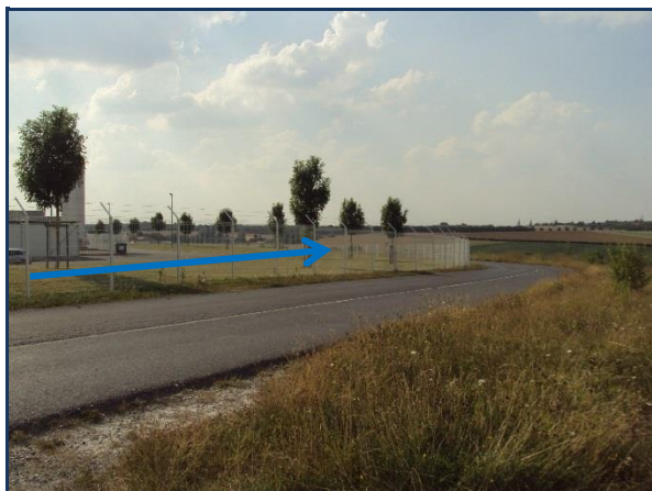
Vue du site au niveau de l'entreprise STELIA
