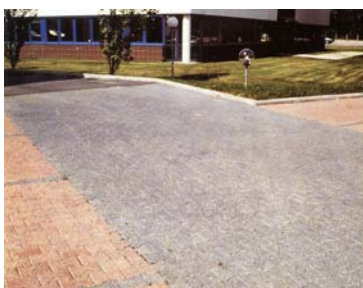
Fig. 7 : Tranchée avec revêtement en pavé drainant
