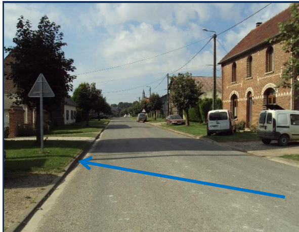
Ruissellements rejoignant les avaloirs de la rue Lepage
