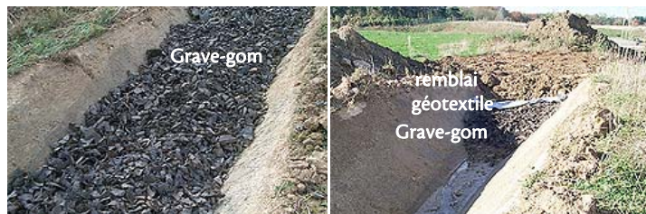
Fig. 10 : Exemple de tranchée constituée de grave-gom
