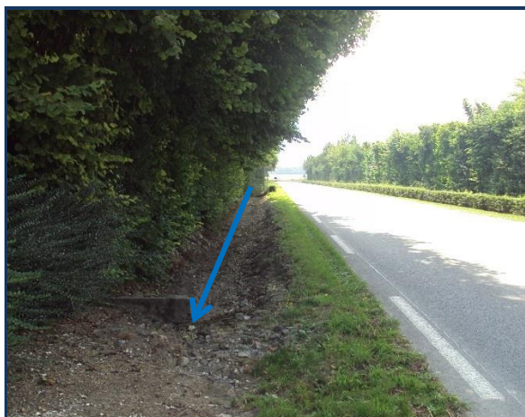
Fossé le long de la route d'Albert
