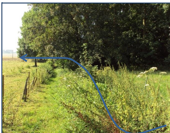
Fossé en aval du château d'eau
