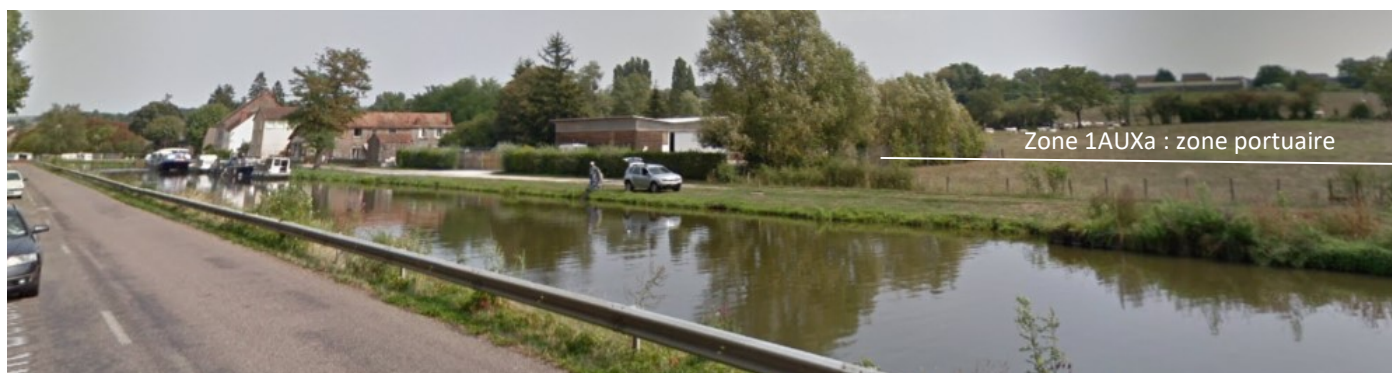
Figure 8 : berges du Canal en façade dégradée de Saint-Léger-sur-Dheune (source : Google Maps, Street View 2021)
