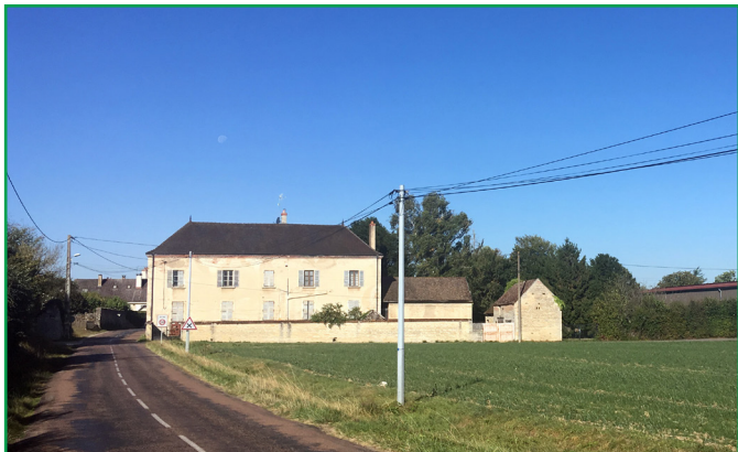
Mur de clôture ancien à Saint-Loup-Géanges
