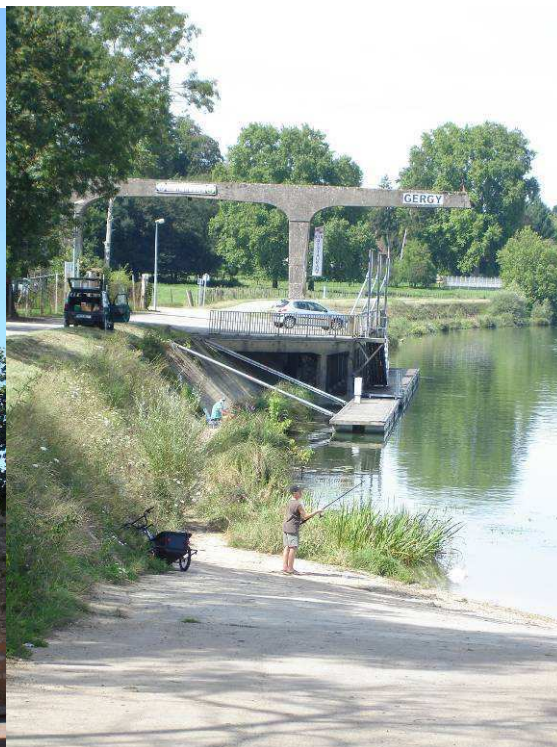
Traces de l'ancien bac
